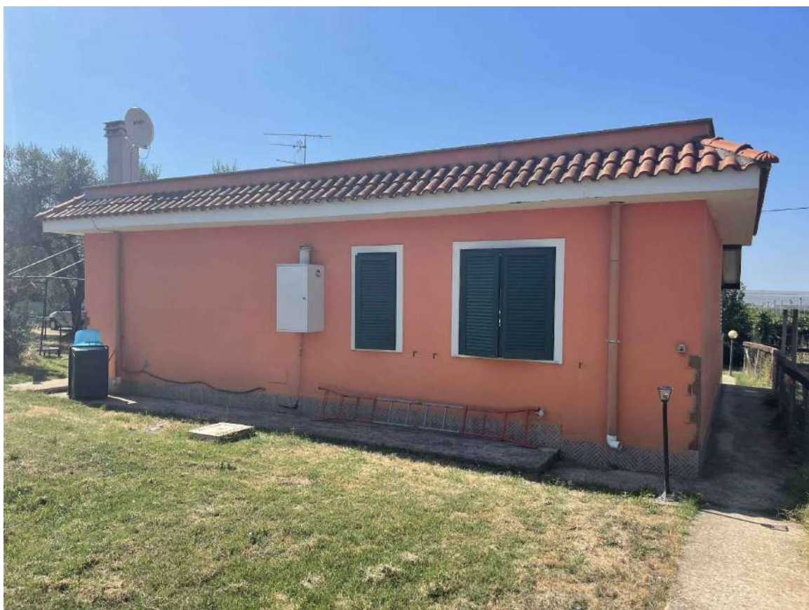
FOTOGRAFIA 2 - ESTERNO - ABITAZIONE - PROSPETTO POSTERIORE
