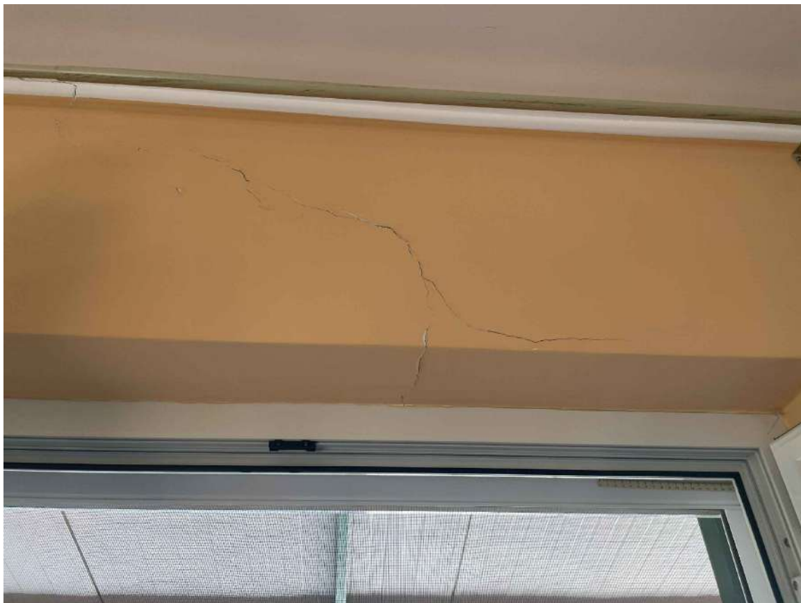
FOTOGRAFIA 20 - INTERNO - ABITAZIONE - SOGGIORNO/PRANZO/A.C.
