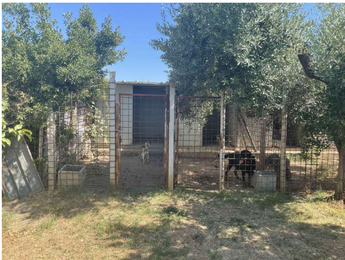
FOTOGRAFIA 8 - ESTERNO - BOX CANI
