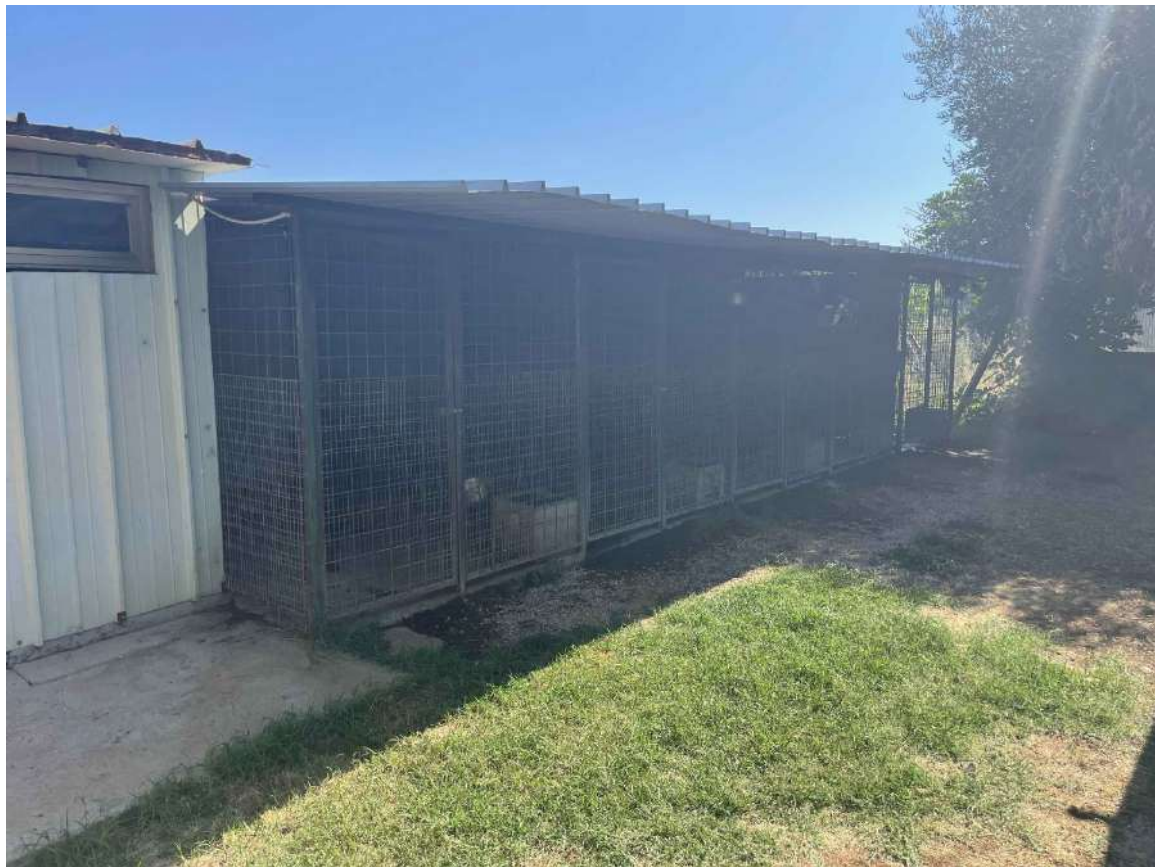
FOTOGRAFIA 11 - ESTERNO - BOX CANI
