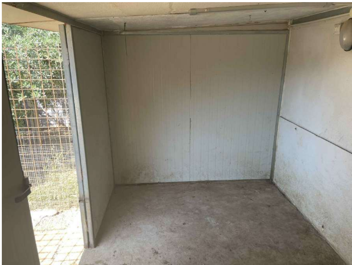
FOTOGRAFIA 13 - INTERNO - BOX CANI
