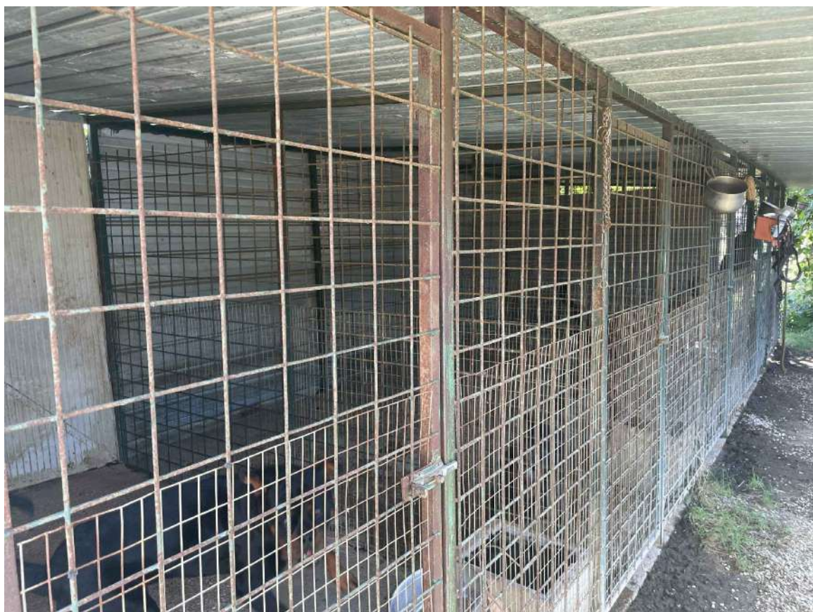
FOTOGRAFIA 12 - ESTERNO - BOX CANI
