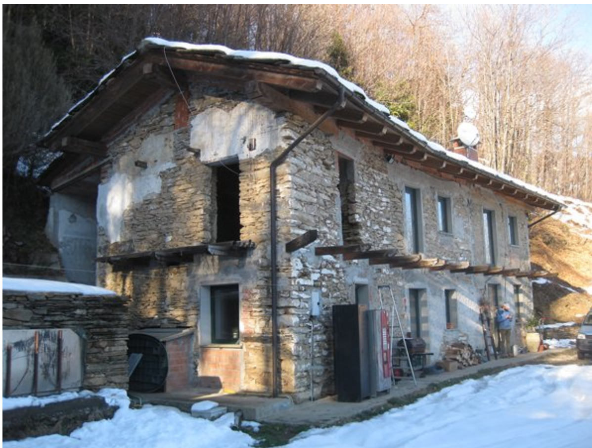
Immobile di Via Bescheis Borello 18/20 a Torre Pellice (TO)
