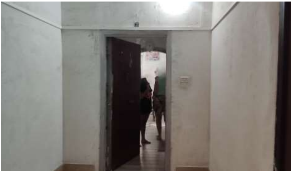
VISTA DELL'INGRESSO ALL'UNITÀ DAL VANO SCALA A
