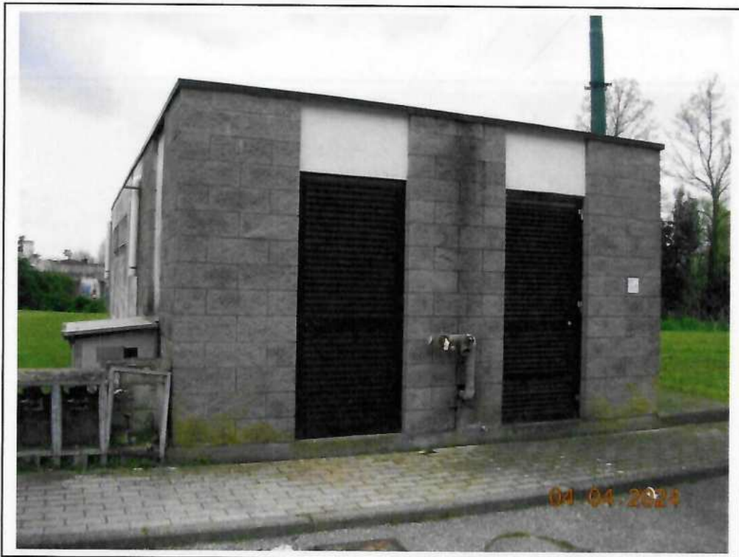
Locale tecnico esterno ( Condominio quadrifoglio )
