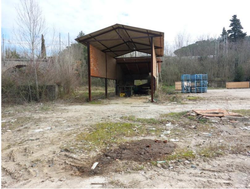
**Foto n.11:** Altro particolare della struttura adibita a magazzino BENE B sul prospetto ovest. Notare la struttura portante in ferro/acciaio con pareti parzialmente tamponate con blocchi forati di laterizio ed esternamente non intonacate e in stato di degrado.
