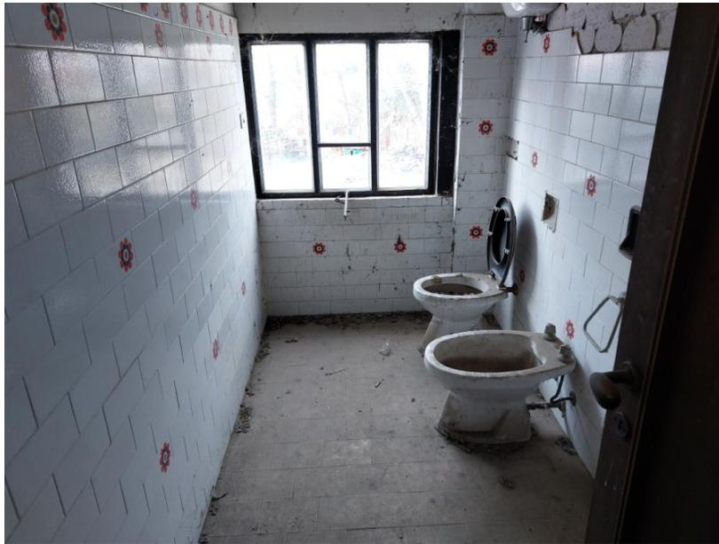
**Foto n.27:** Particolare del W.C. al piano primo (BENE E). Sono visibili in foto , la dotazione di sanitari, le pareti parzialmente rivestite con piastrelle di ceramica e il pavimento in monocottura.
