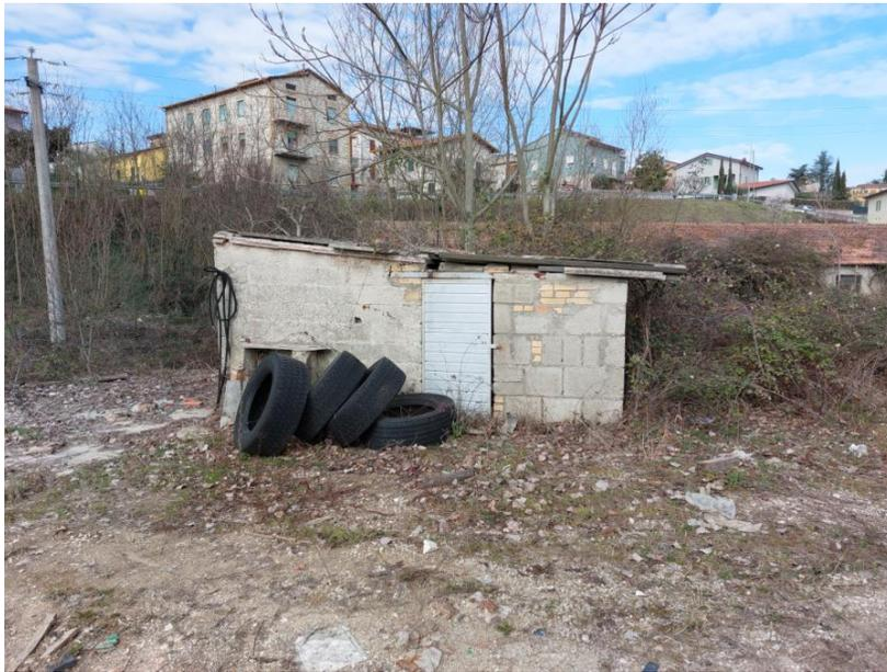
**Foto n.13:** Particolare della piccola struttura adibita a magazzino BENE C sul prospetto sud. Notare il tetto con copertura piana e la struttura in muratura mista.
