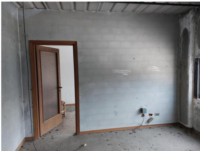
**Foto n.28:** Particolare dell'ufficio al piano primo (BENE E). È visibile, sulla sinistra dell'immagine, l'apertura di accesso all'altro ufficio. Notare la porta in legno e vetro smerigliato, gli impianti elettrici realizzati sottotraccia e le pareti intonacate e tinteggiate.
