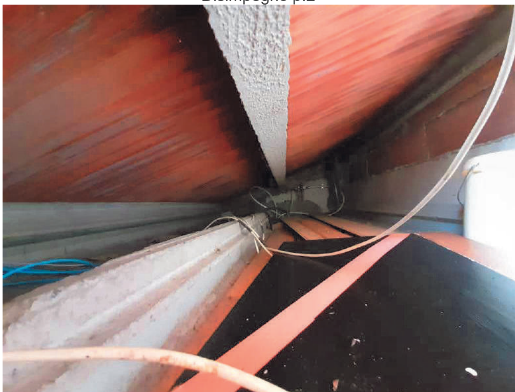
Sottotetto non abitabile
