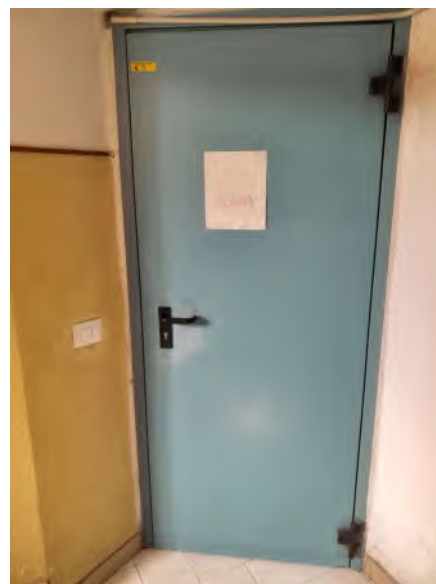
FOTO 7: PORTA REI A SEPARAZIONE VANO SCALA
