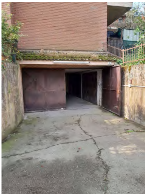
FOTO 8: AREA E PORTONE ACCESSO AREA MANOVRA BOX
