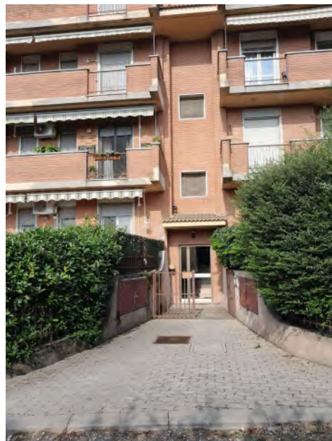
FOTO 9: ACCESSO PEDONALE VANO SCALA
