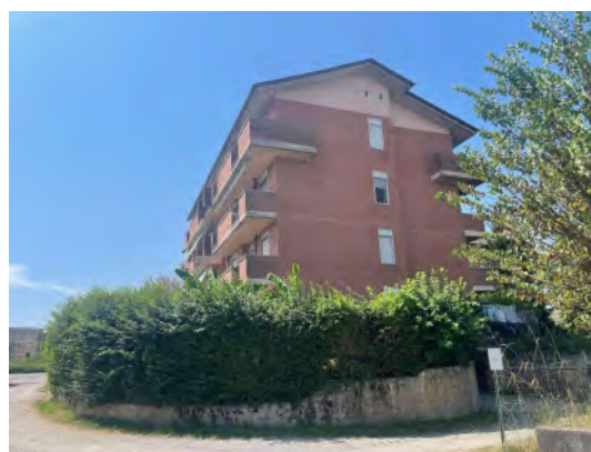
FOTO 2: PROSPETTO VERSO ENTRATA CARRAIA
