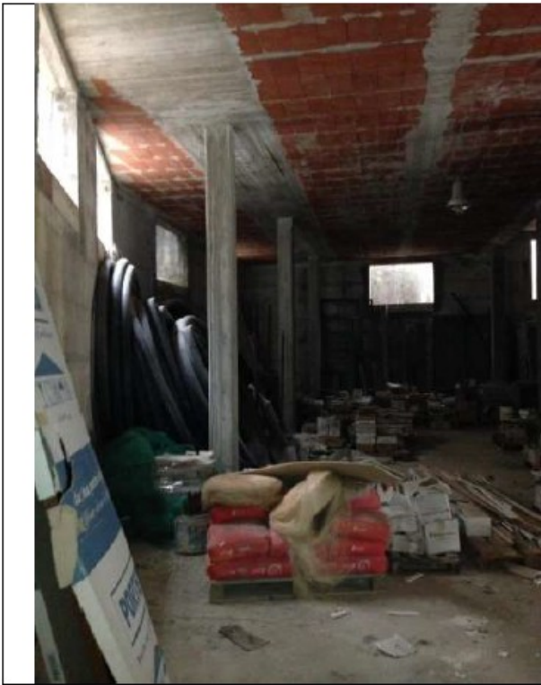
Foto 48. Particolare del magazzino interrato.
