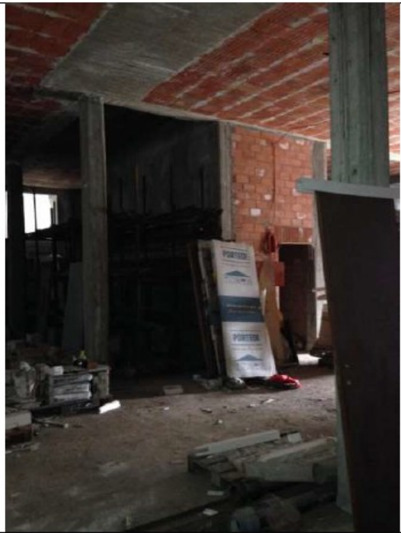
Foto 49. Particolare del magazzino interrato.
