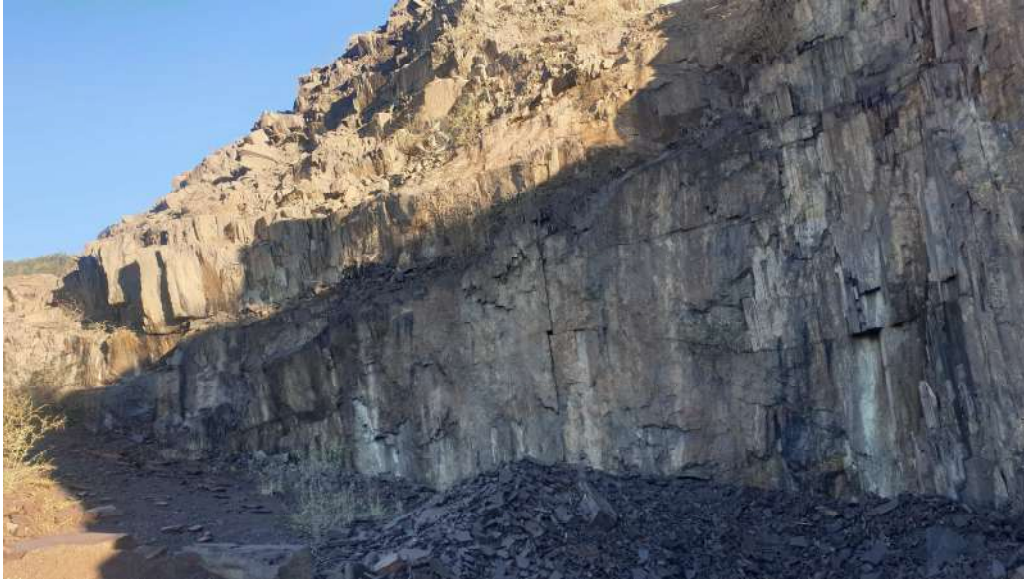
Foto da valle verso monte P.fond. 2501
