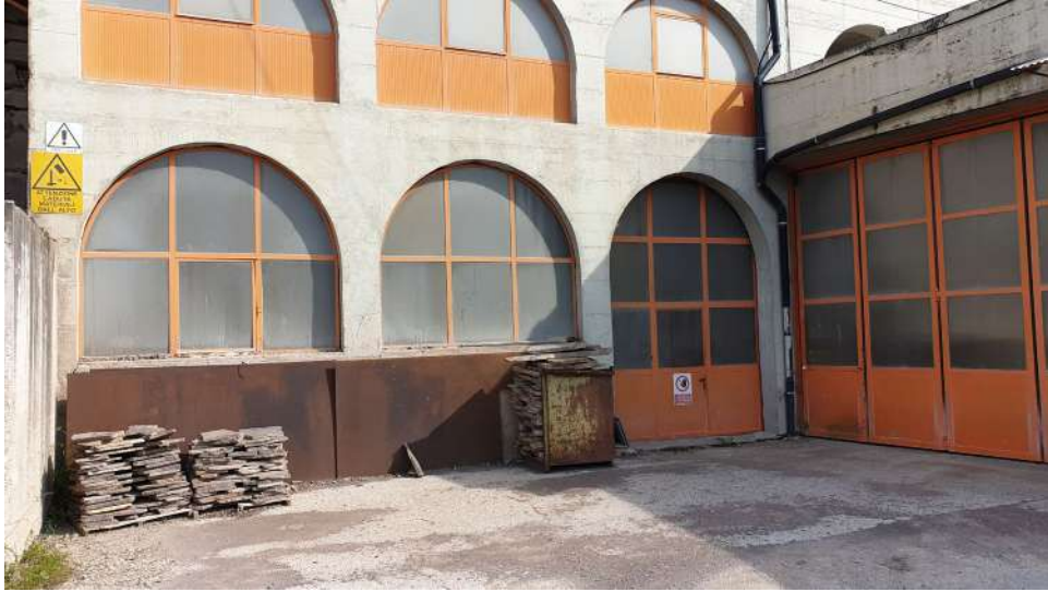
LATO SUD - PIANO TERRA
