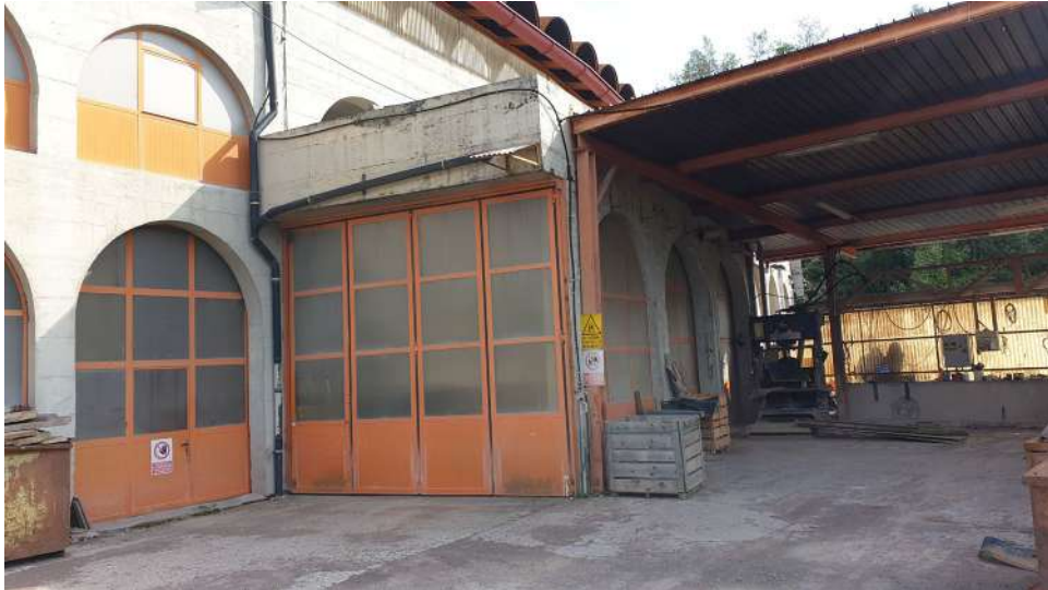
LATO SUD - PIANO TERRA
