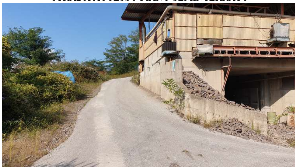
STRADA ACCESSO PIANO SEMINTERRATO
