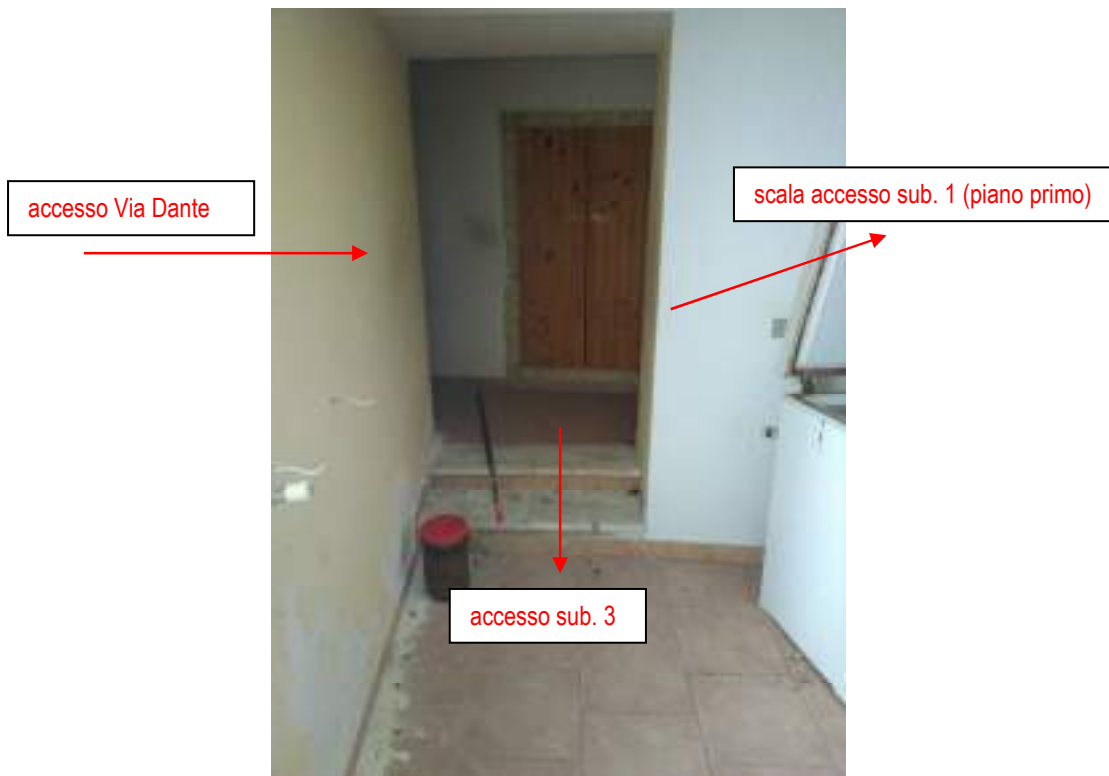
Foto 1.C: pianerottolo di ingresso interno dalla Via Dante n. 6
