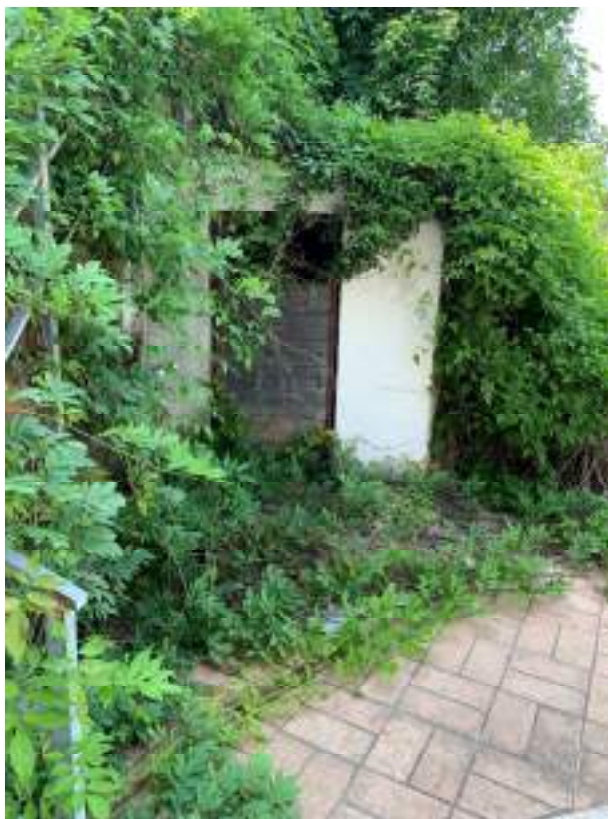
Foto 3.A: magazzino/deposito lato nord
