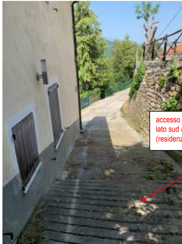
Foto 1.2: viste fabbricato dalla Via Dante 10 (pedonale)
