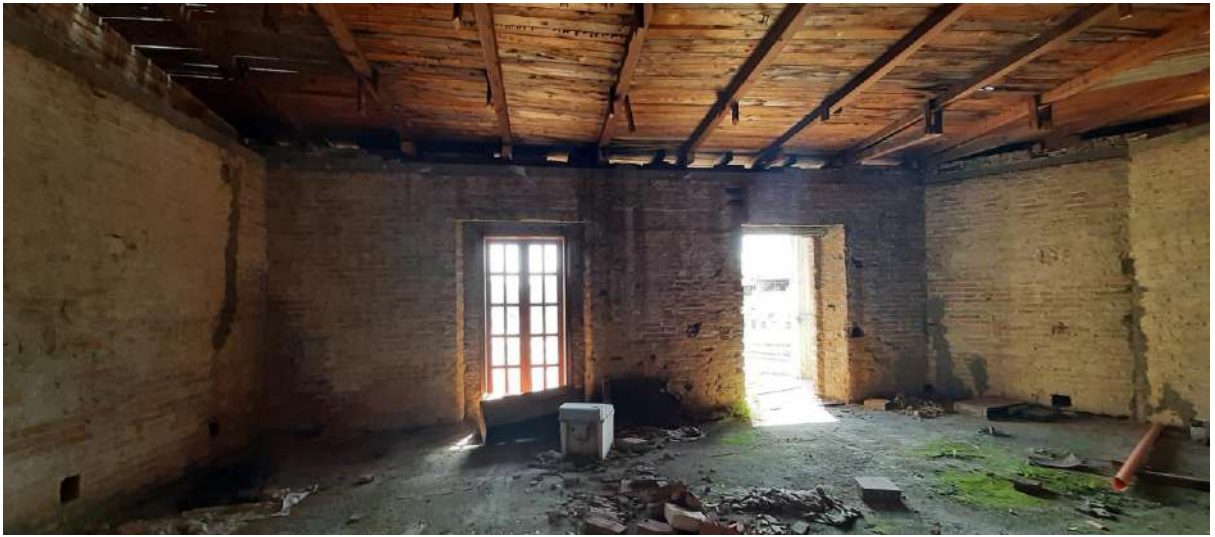
Foto 16-17-18: interno abitazione al piano primo
