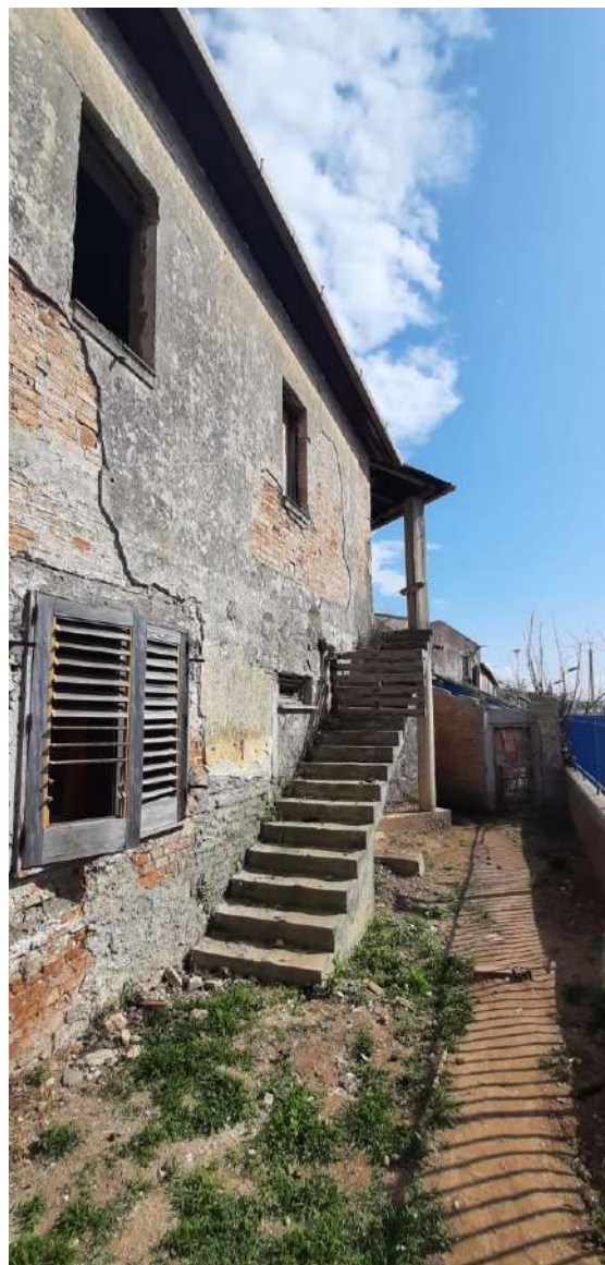
Foto 11: scala d'accesso al piano primo
