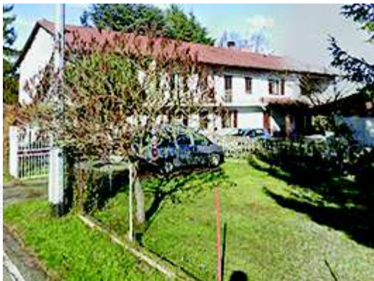
Foto 1: il fabbricato residenziale
