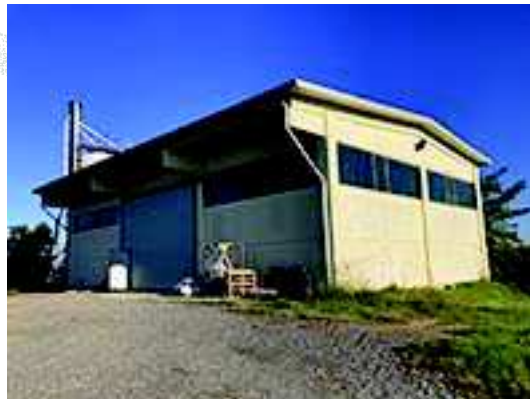
Foto 2: il capannone agricolo da sud
