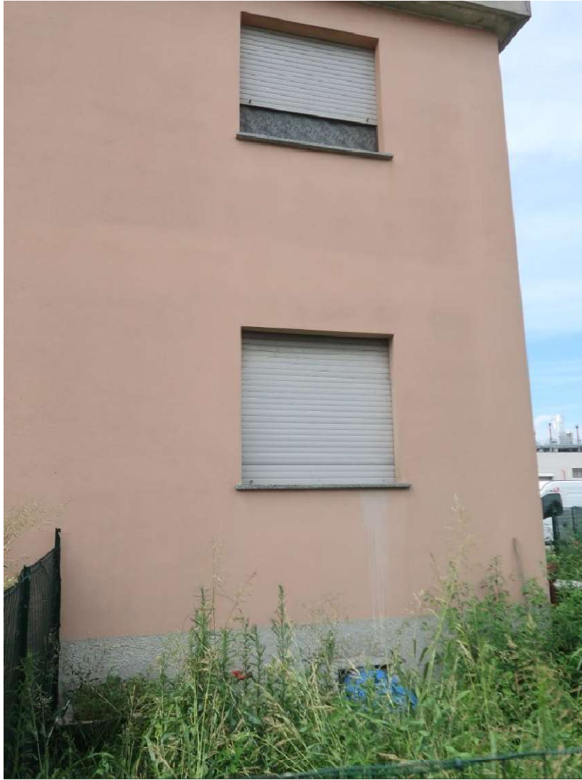
FACCIATA SU LATO INTERNO
