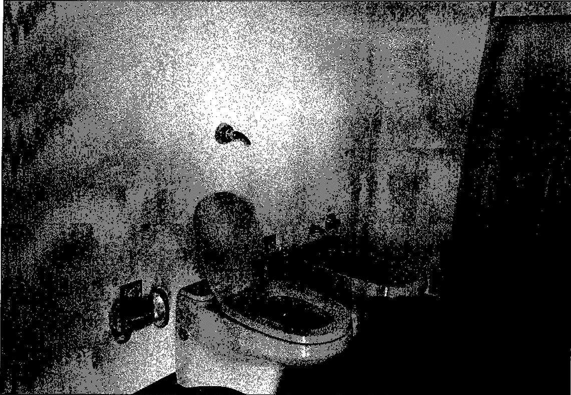
Foto 15: Vista interna bagno piano primo
