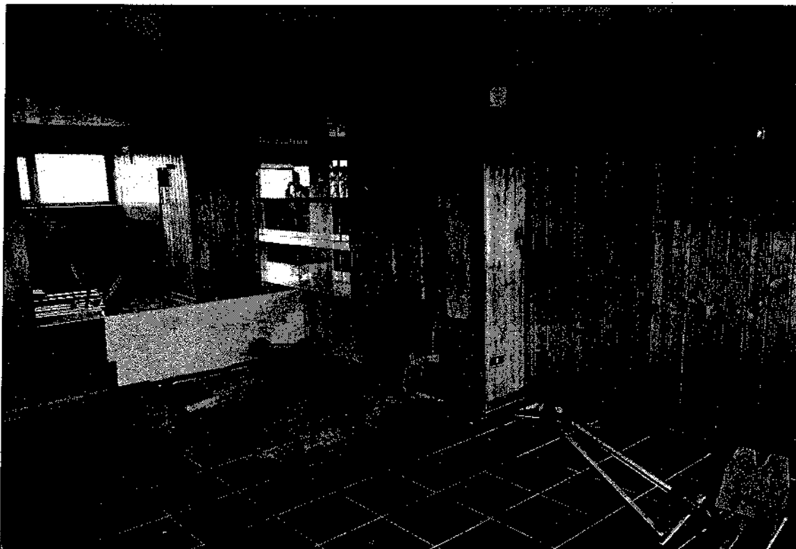
Foto 20: Vista interna piano sottotetto
