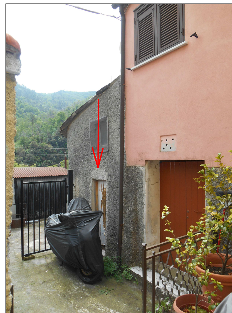
Accesso del ripostiglio esterno
