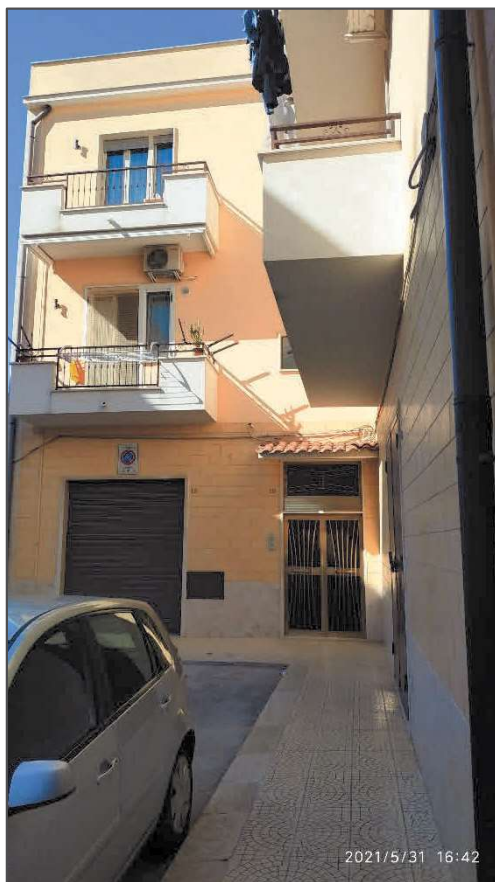
Foto 2 – Vista Prospetto sud
