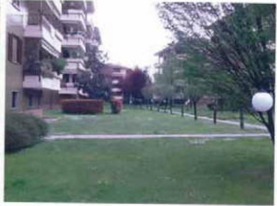
Vista del compendio condominiale
