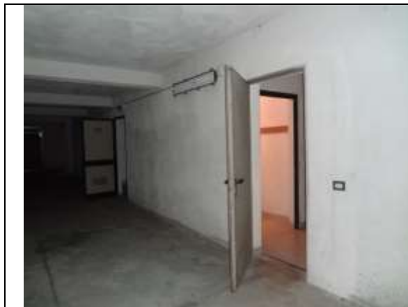
Foto 9 Particolare Accessi Lotto 3
