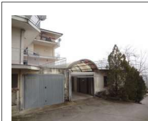
Foto 1 Particella accesso al piano S1
