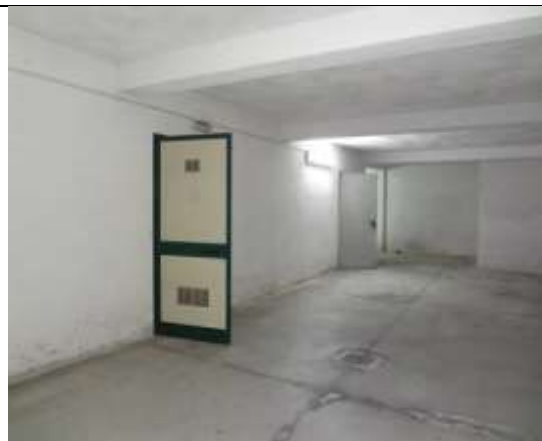
Foto 10 Particolare Accessi Lotto 3
