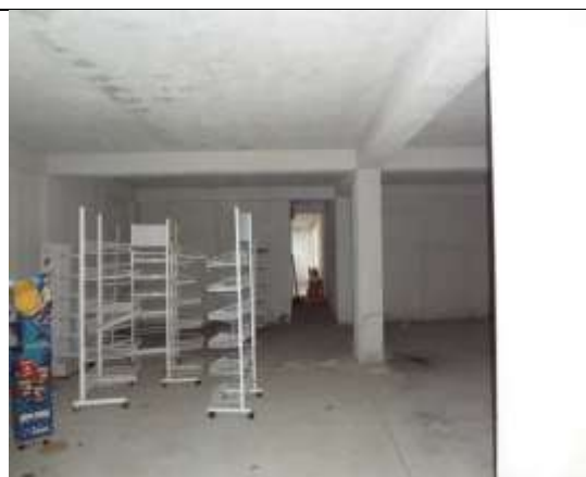
Foto 4 Vista interna locale
