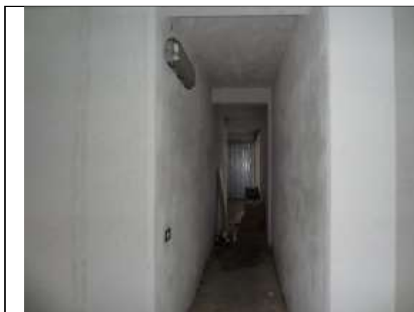
Foto 3 Particolare corridoio comune -ovest
