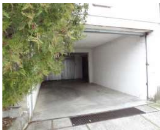
Foto 2 Particella accesso al piano S2
