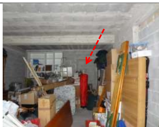
Foto 20 Particolare porta murata
