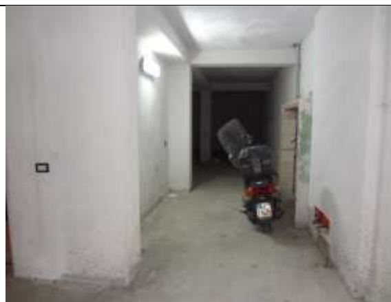
Foto 6 Particolare accesso – sud-est
