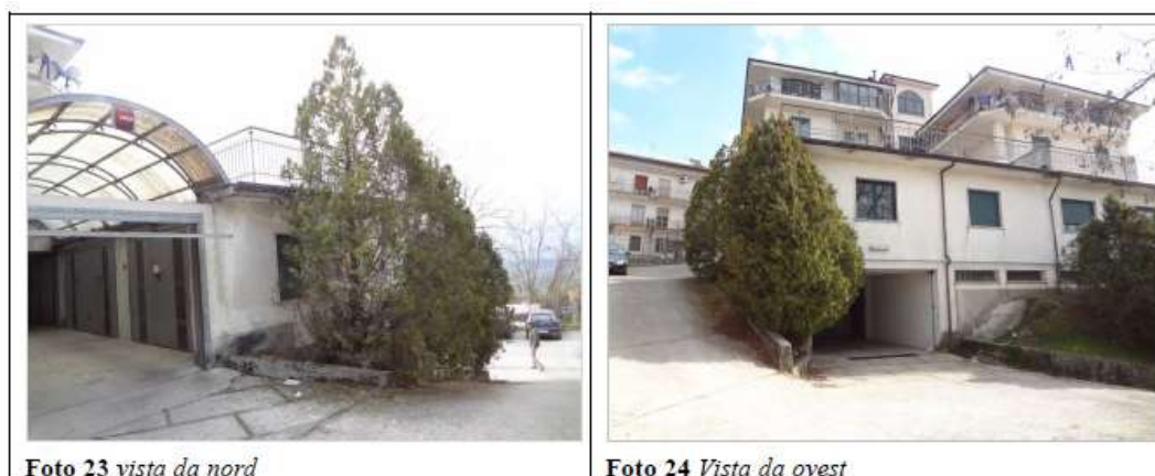
Foto 23 vista da nord
