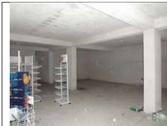
Foto 5 Vista interna locale
