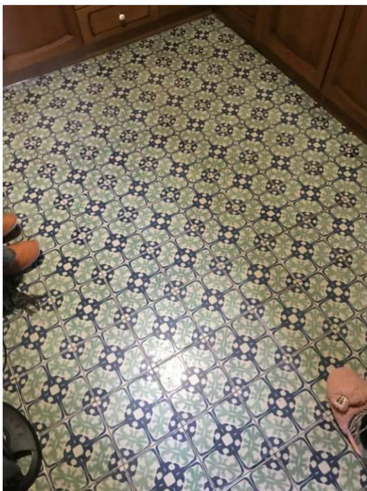
Pavimentazione in gres porcellanato
