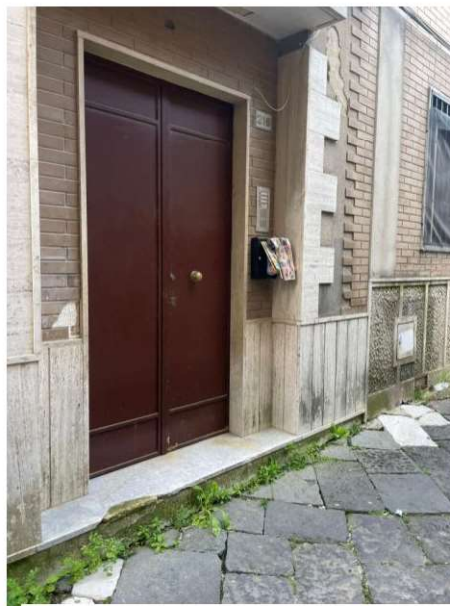
Accesso alla scala condominiale
