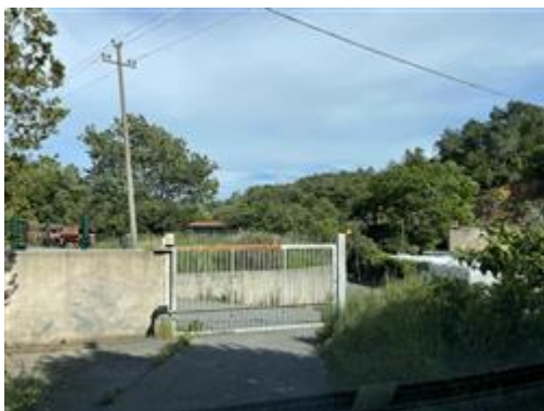
CANCELLATA DI ACCESSO ALLA STRADA POSIZIONATE IN ALTRA PROPRIETA'ESTRANEE AL PRESENTE PIGNORAMENTO
