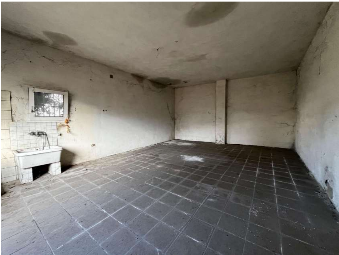
35. interno garage, verso Nord
