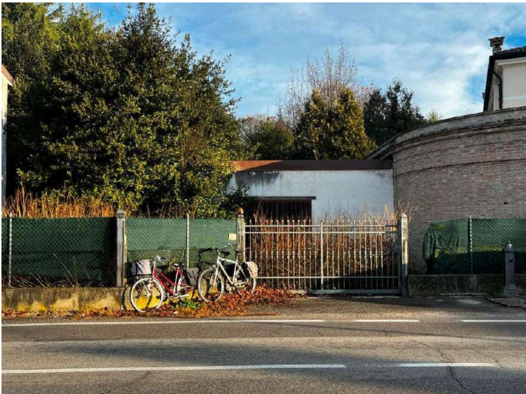
4. accesso carraio e garage
