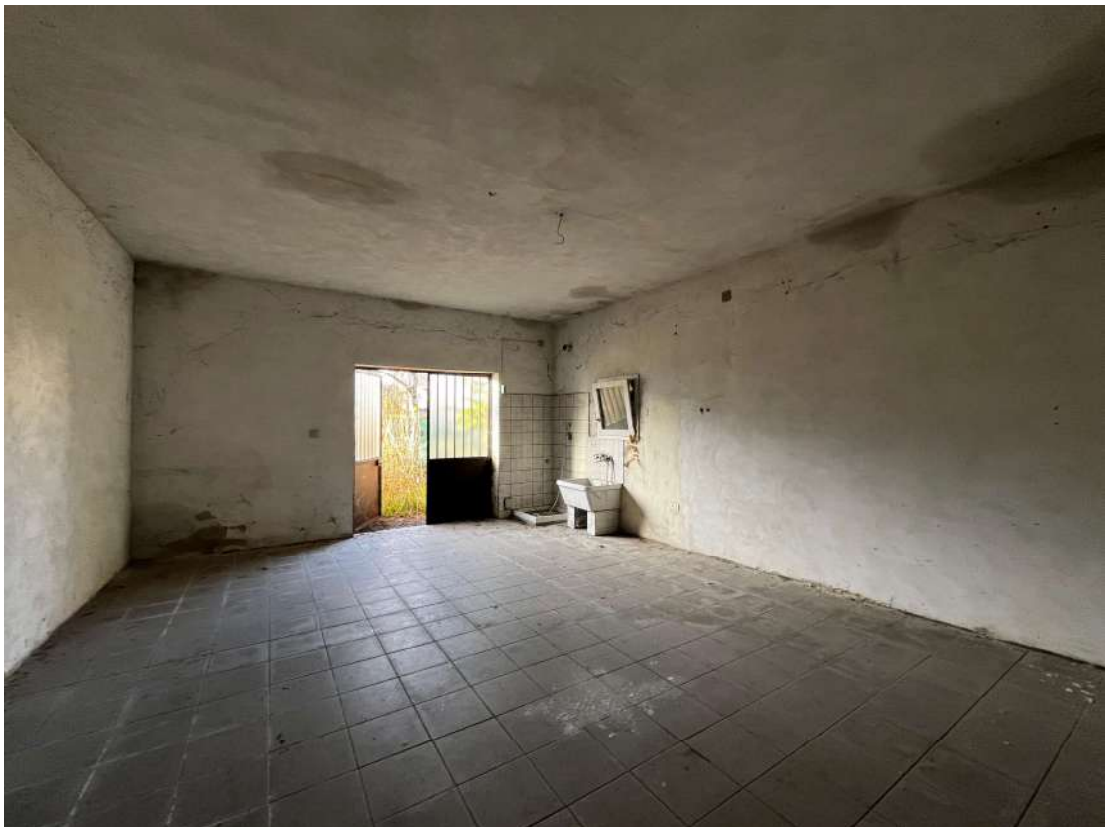
36. interno garage, verso Sud
