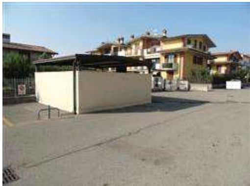
Manufatto edilizio costruito sull'area occupata dal posto auto sub. 3
