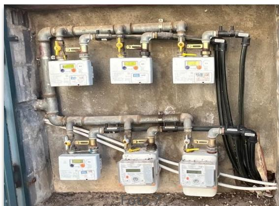
Dalla condotta di PE a valle del contatore conformemente alla UNI 7129 si raggiunge il tratto fuori terra in acciaio zincato dal quale si raggiunge, lungo la facciata (vedi foto 8), il generatore di calore collocato all'esterno nel balcone in adiacenza alla cucina e "l'apparecchio di cottura a gas" collocato nel locale ad uso cucina.
