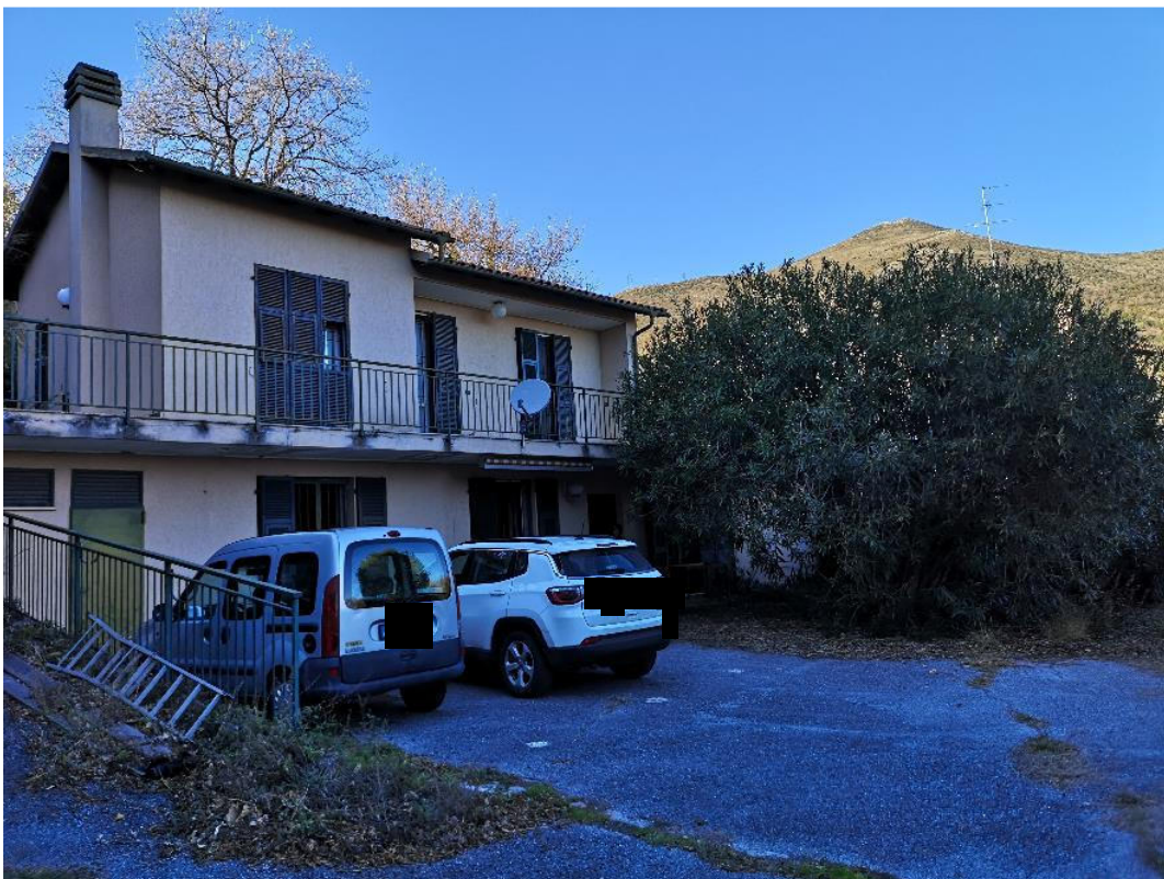
foto 2: fronte sud est
