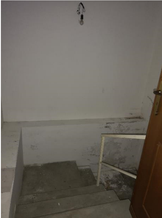
Foto 6: scale interne al locale cantina interrata
