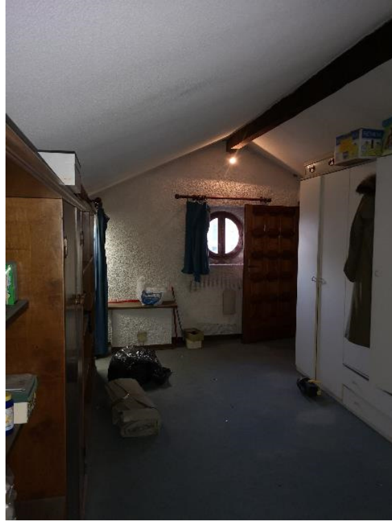
Foto 2: ingresso da vano scale
