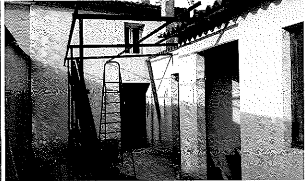
Prospetto su cortile interno
