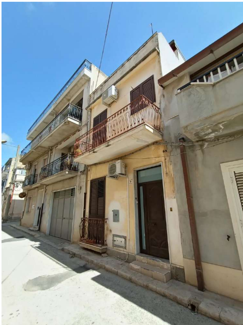
Foto 1. Vista esterna dell'edificio su via Savarino n. 9.
