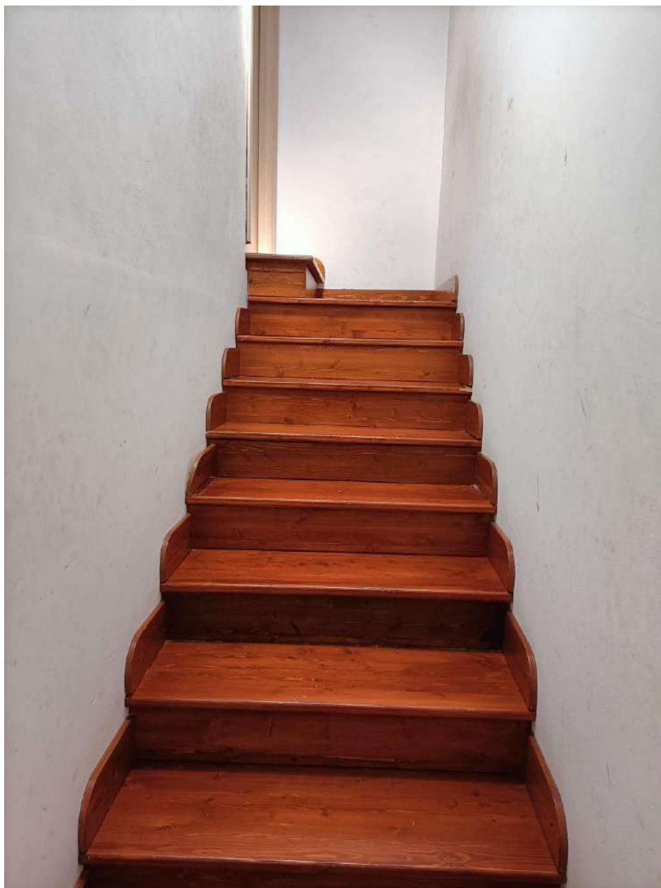
Foto 10. Vista della scala interna di collegamento tra piano primo e secondo.
