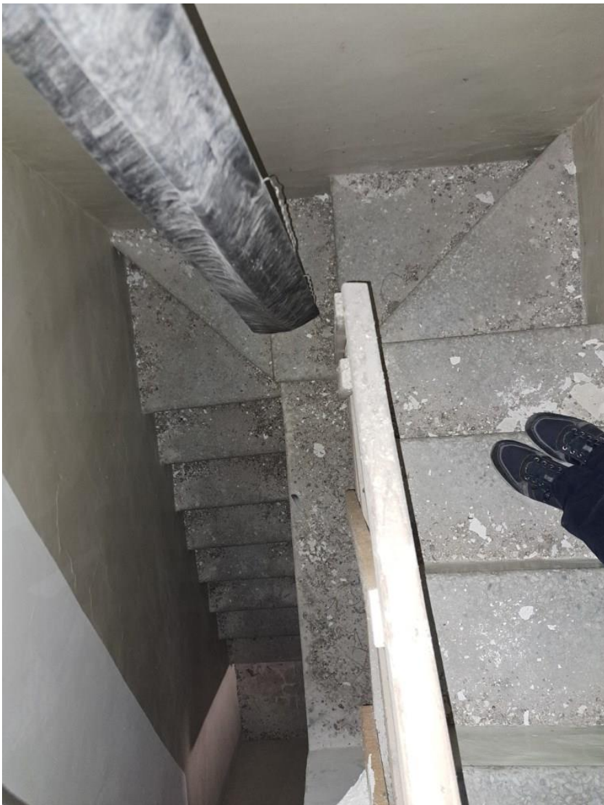
Foto 14 – vano scala interno all'alloggio
