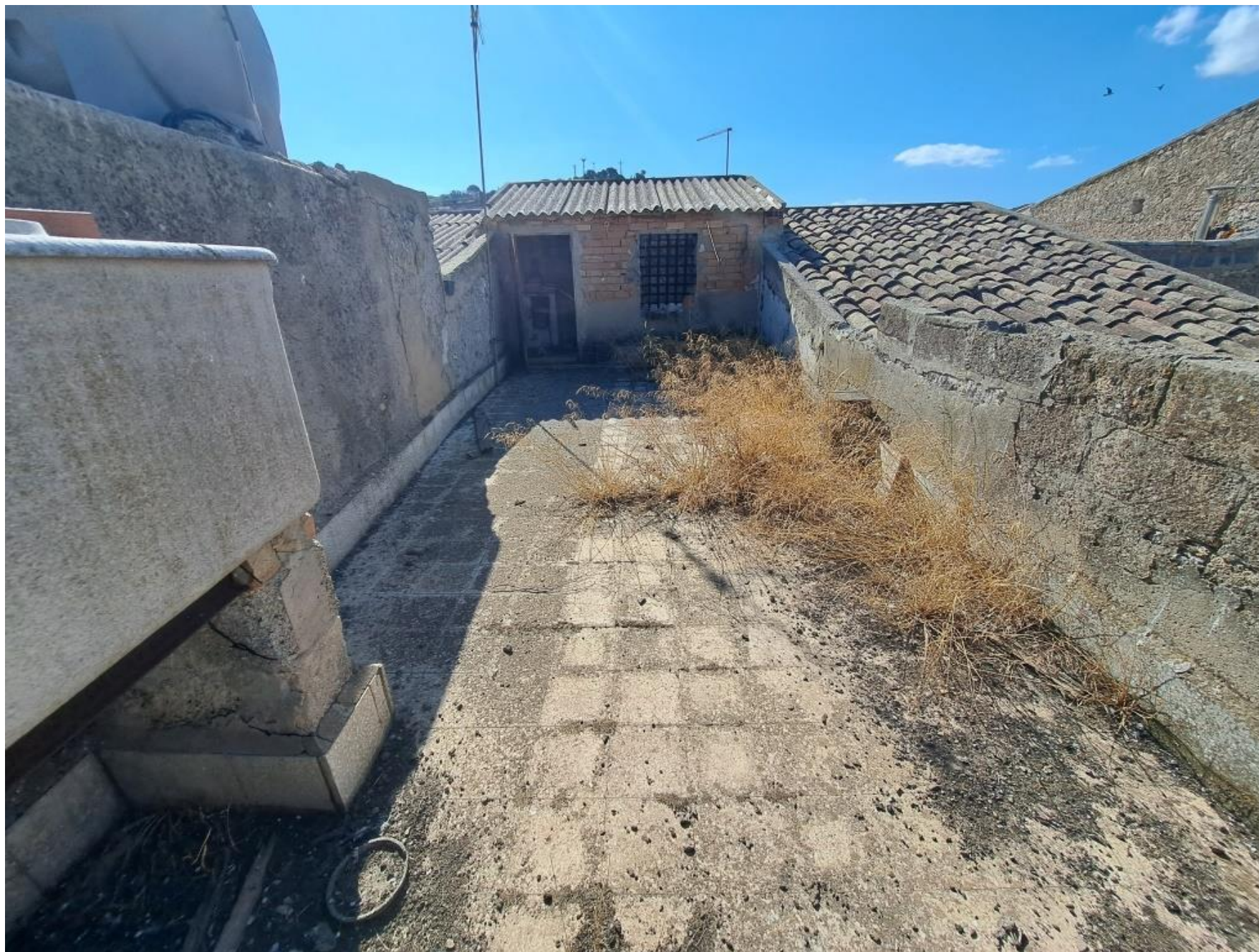
Foto 16 – Terrazza al terzo piano e torrino scala
