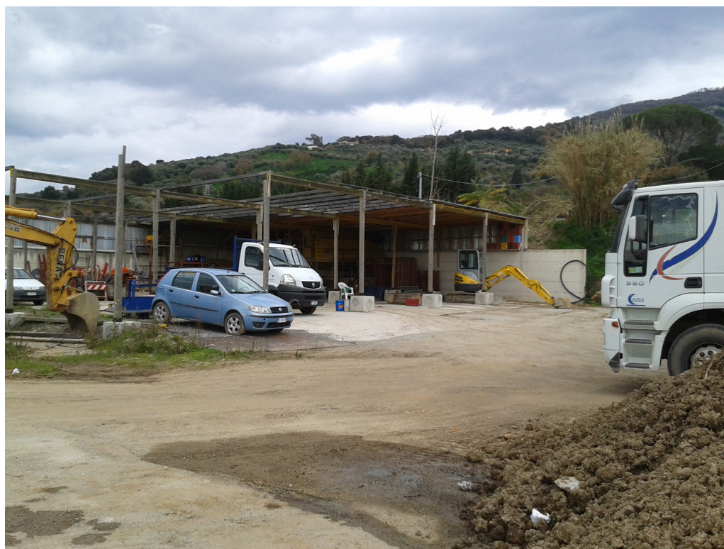
Piazzale con tettoia in struttura precaria
