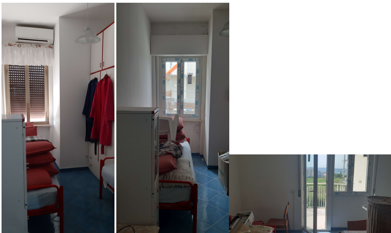
Foto 3 tipologia infisso appartamento prima e dopo intervento 110%
