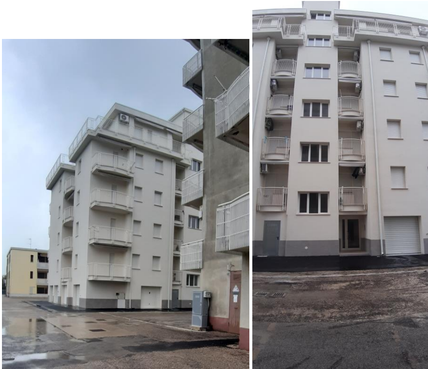
FOTO 1: vista prima durante e dopo i lavori
