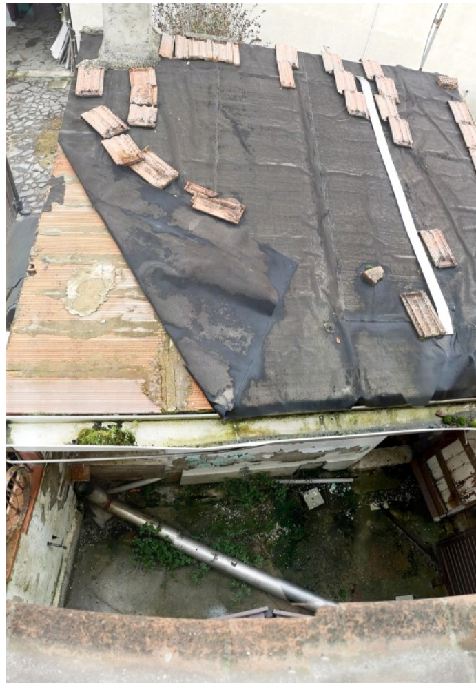
COPERTURA RIPOSTIGLIO ESTERNO
