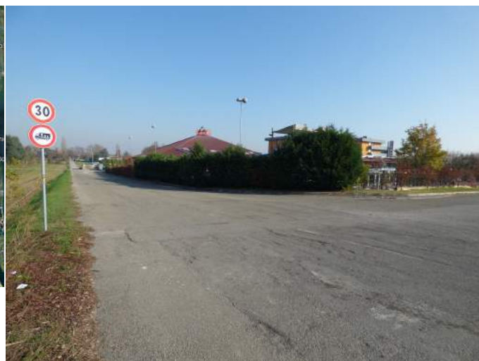
stradello laterale sx
