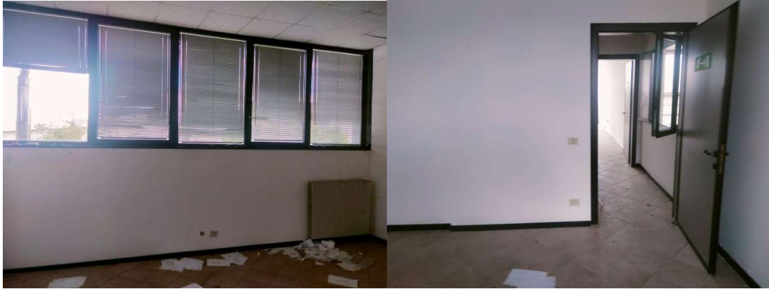
Ufficio lato Nord primo piano
