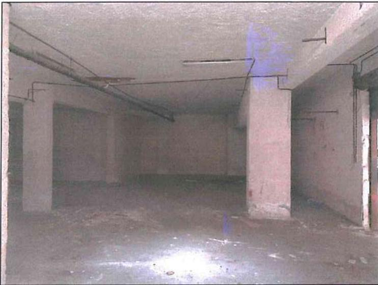
**Foto 13-14 - Altre viste interne del garage sul lato confinante con garage di altra proprietà. Esso è dotato di impianto di illuminazione dismessa. Sul lato inferiore delle pareti è presente umidità.**
