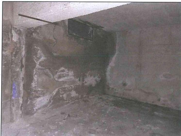
**Foto 18 - 19 - In particolare la parete dove vi sono le aperture, presenta vistoso stato di degrado costituito da umidità e muffe a causa di infiltrazioni d'acqua. Occorrono lavori di manutenzione.**
