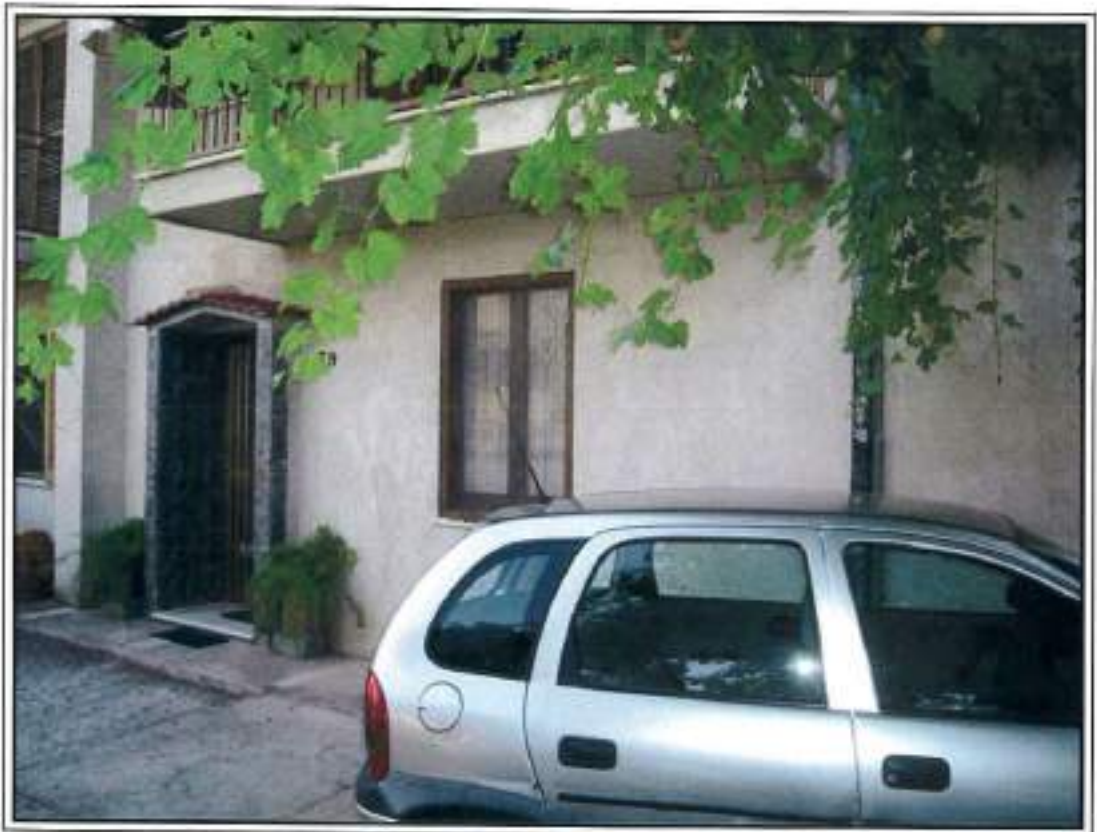
Foto n E-23: Corte esterna.
