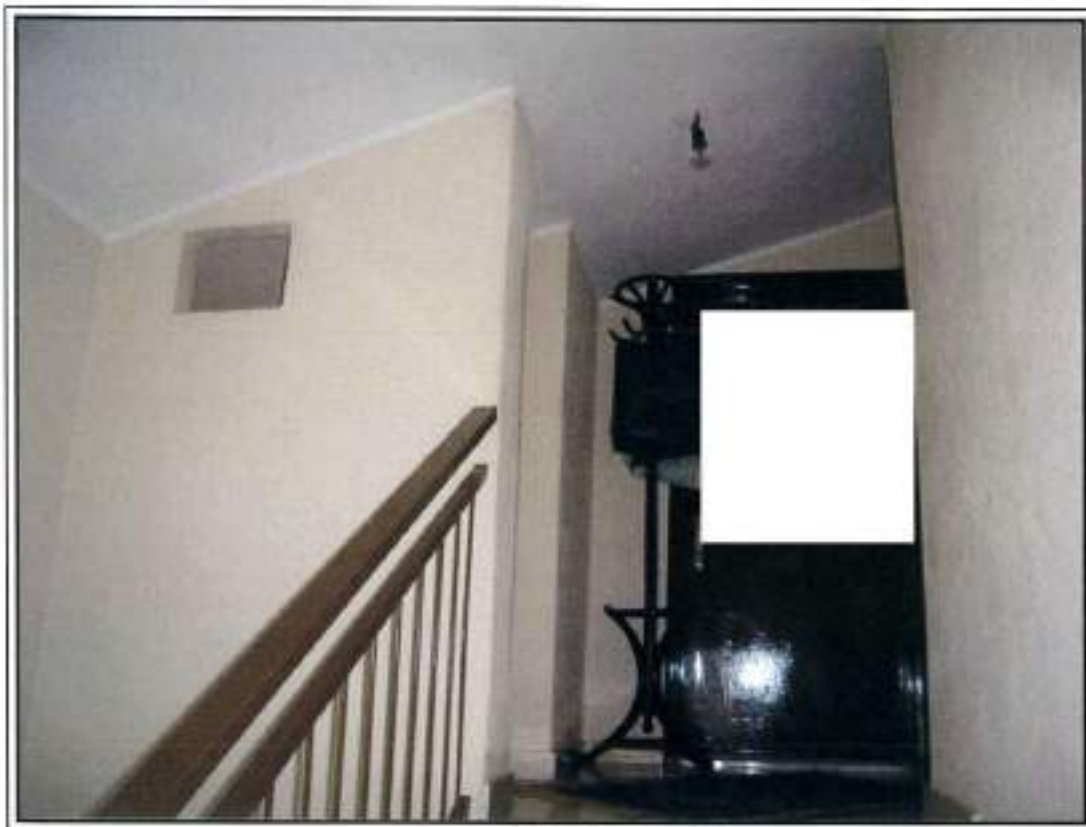
Foto n E-15: Corpo scala.
