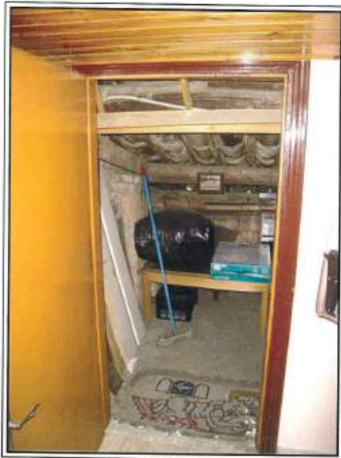
Foto n E-19: Sottotetto.
