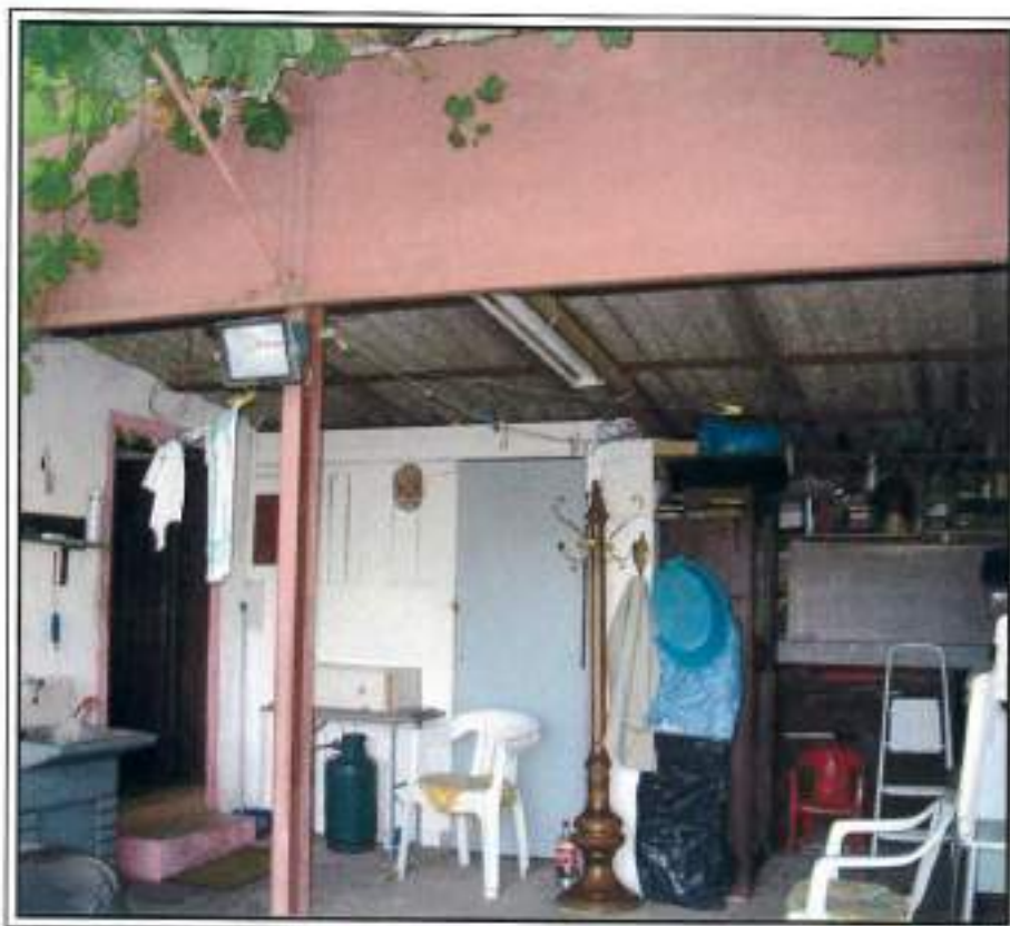
Foto n E-25: Corte esterna.
