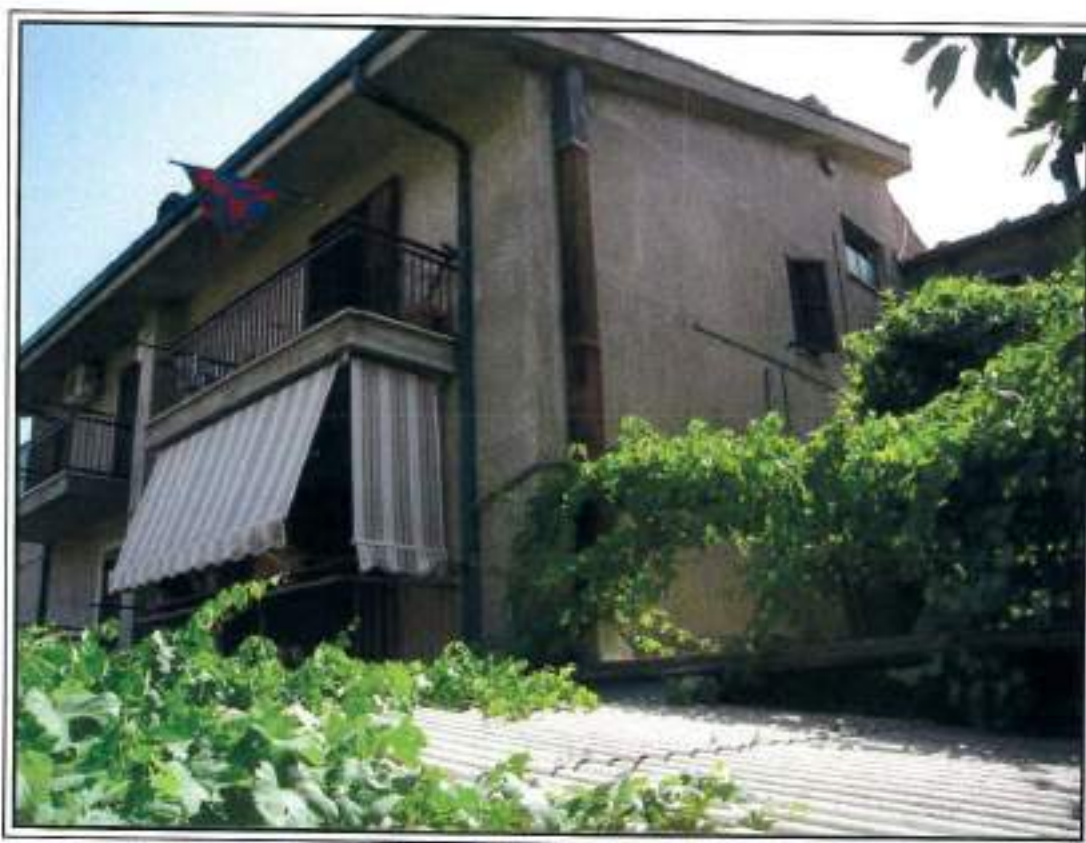
Foto n E-27: Corte esterna.
