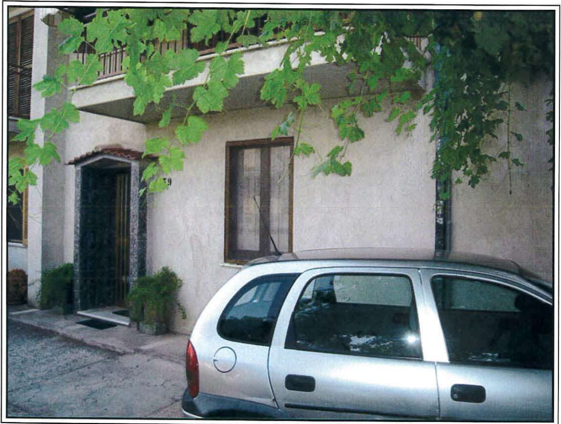
Foto n E-23: Corte esterna.
