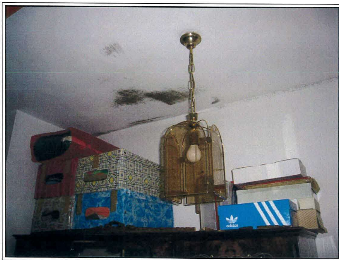
Foto n E-8: Disimpegno.
