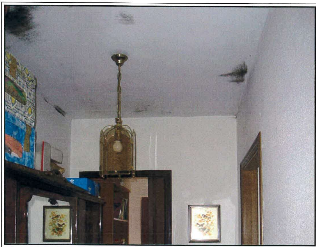
Foto n E-7: Disimpegno.
