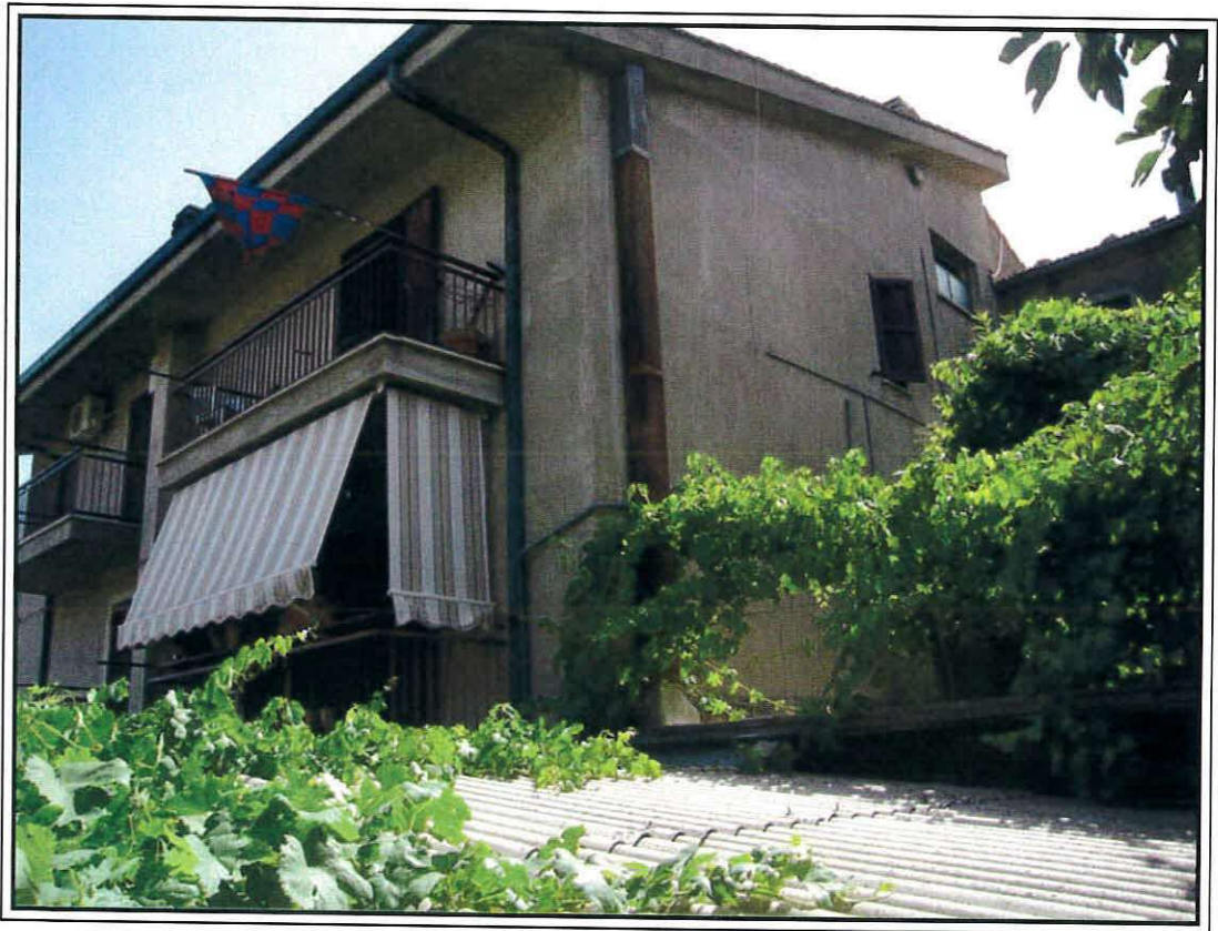
Foto n E-27: Corte esterna.
