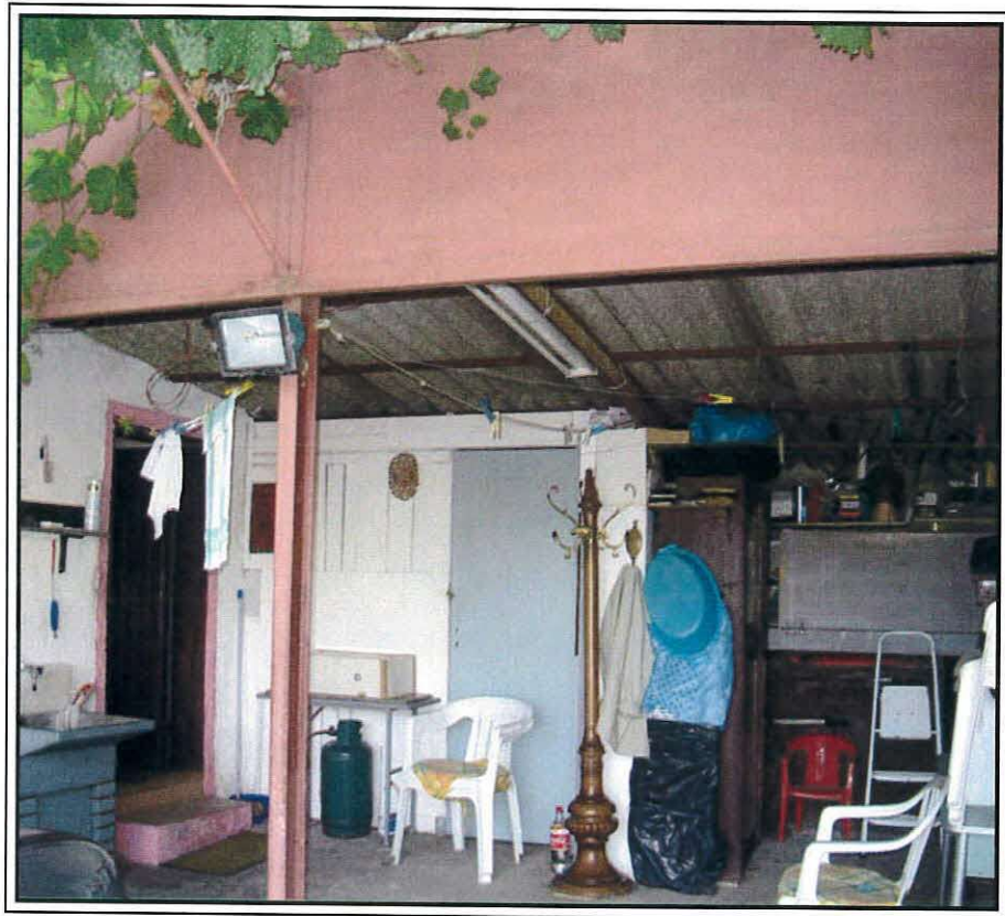
Foto n E-25: Corte esterna.
