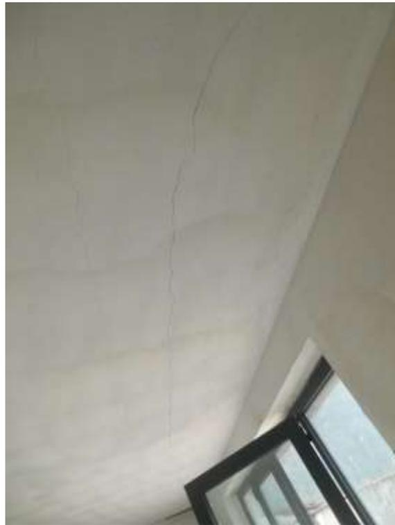
Fotografia 13 – Veduta della crepa presente nel solaio di soffittatura del vano 4, in corrispondenza di uno dei travetti del solaio
