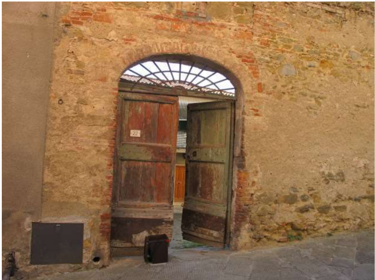
Ingresso da via Pissuti n. 22
