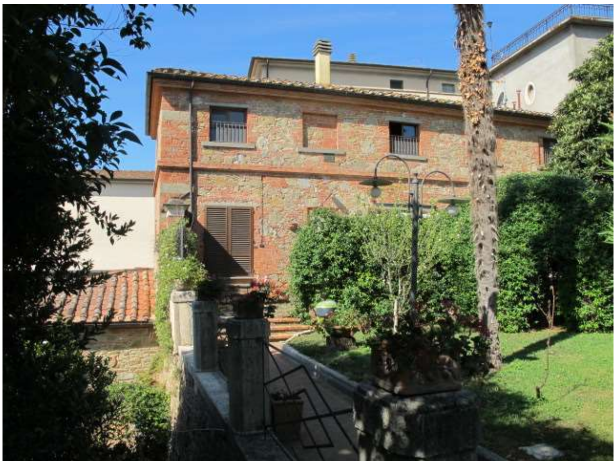
Esterno dell'edificio (da cui si accede dalla corte censita alla p.lla 436)
