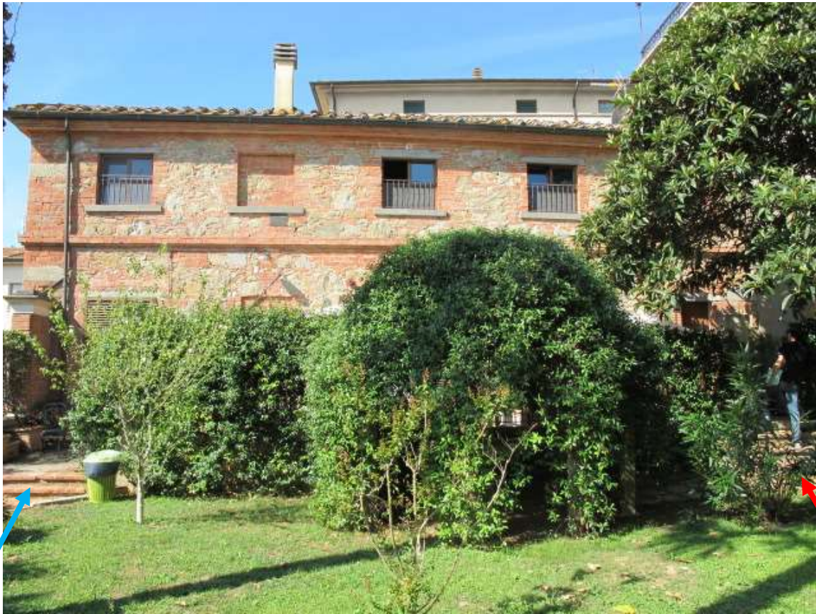
Ingresso del lotto n. 1 (evidenziato con freccia azzurra) e del lotto n. 2 (evidenziato con freccia rossa)
