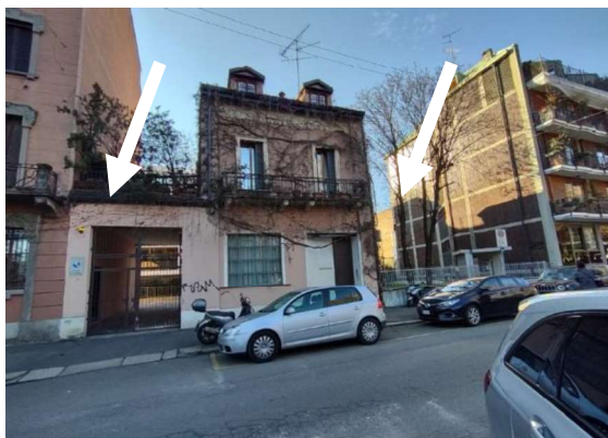
Fronte strada: accesso carraio e pedonale
