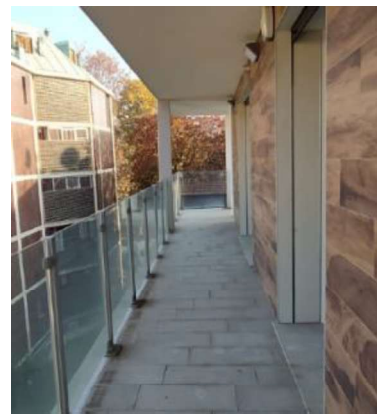
Balcone del complesso
