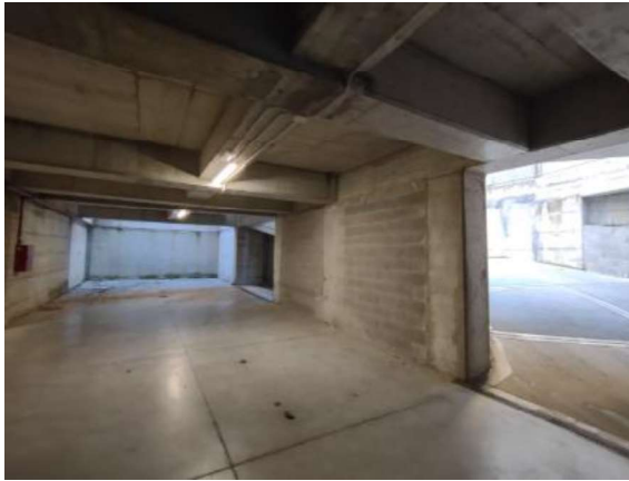
Interno del parcheggio interrato
