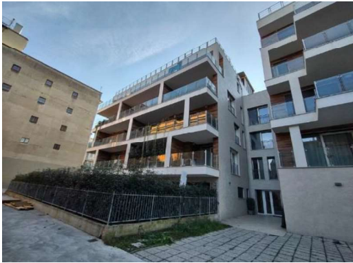
Ingresso al fabbricato
