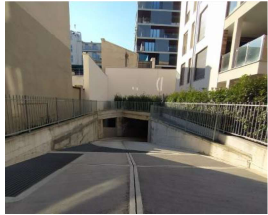
Rampa ingresso carraio
