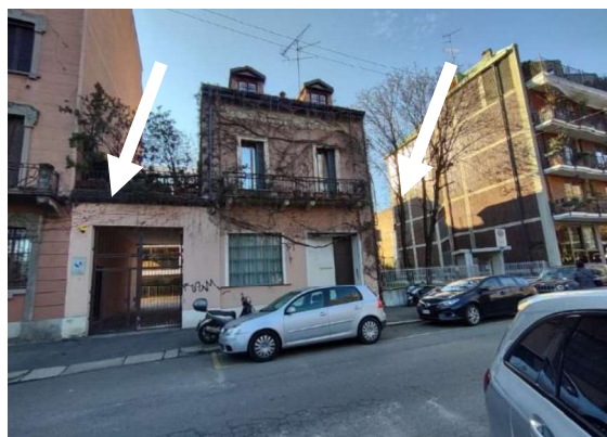
Fronte strada: accesso carraiò e pedonale
