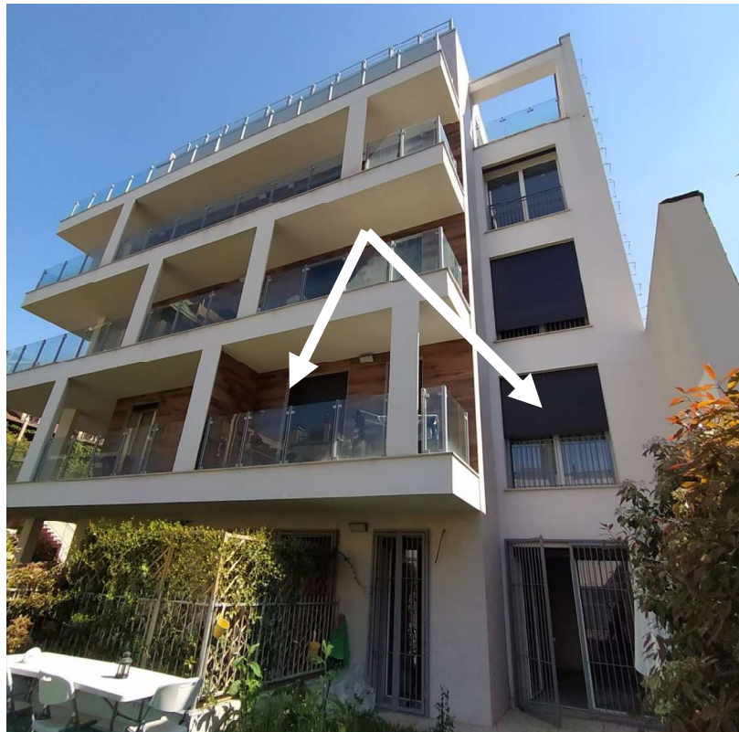
Posizione dell'abitazione oggetto di stima
