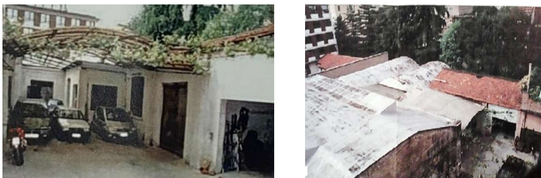
Fotografia del lotto antecedente ai lavori
