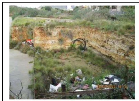
Foto 89. Scavo di sbancamento del prolungamento dell'edificio in corso in costruzione
