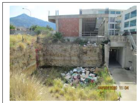
Foto 90. Scavo di sbancamento del prolungamento dell'edificio in corso in costruzione
