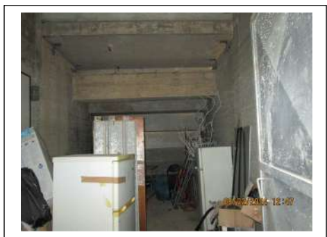
Foto 51. Locale di sgombero sotto la gradonata esterna
