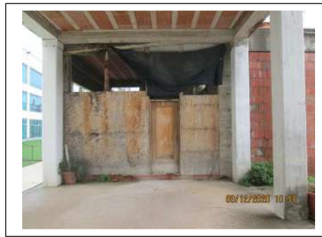
Foto 84. Edificio in corso di costruzione. Zona di ingresso
