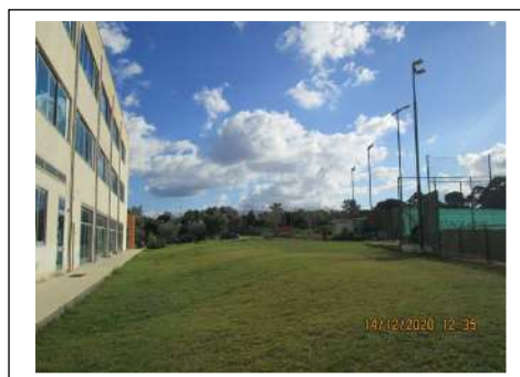
Foto 6. Edificio non pignorati facenti parte del complesso scolastico. Veduta del fronte ovest e di parte dei campi da tennis
