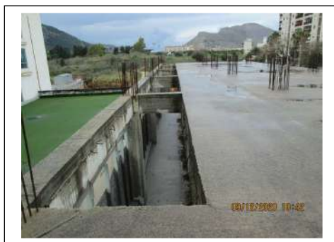
Foto 77. Edificio in corso di costruzione. Estradosso del solaio del piano terra
