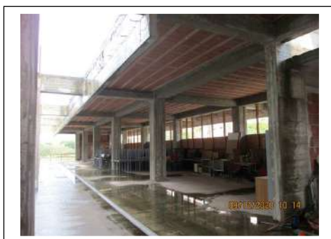
Foto 85. Edificio in corso di costruzione. Interno
