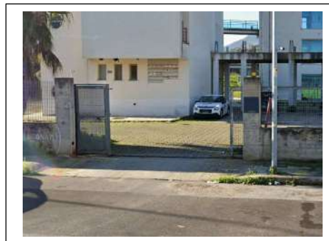
Foto 72. Ingresso da via Eleonora Duse n. 2
