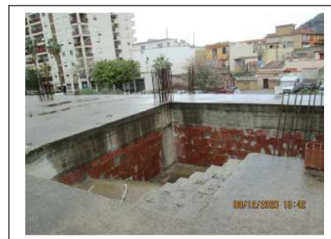
Foto 79. Edificio in corso di costruzione. Estradosso del solaio del piano terra e corpo scala
