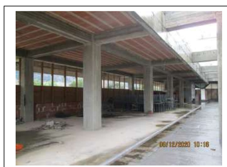
Foto 86. Edificio in corso di costruzione. Interno
