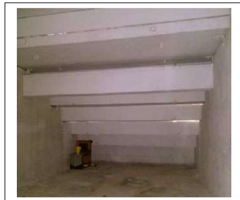
Foto 52. Locale di sgombero sotto la gradonata esterna
