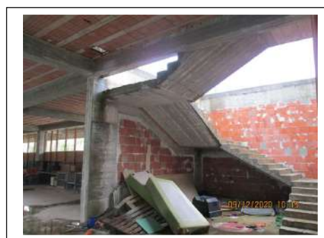
Foto 82. Edificio in corso di costruzione. Corpo scala
