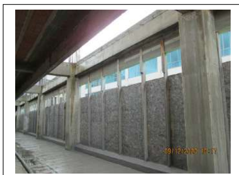
Foto 87. Edificio in corso di costruzione. Interno
