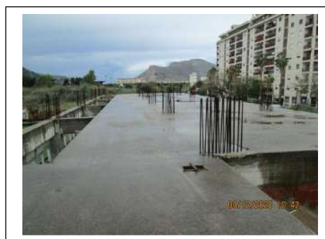
Foto 78. Edificio in corso di costruzione. Estradosso del solaio del piano terra
