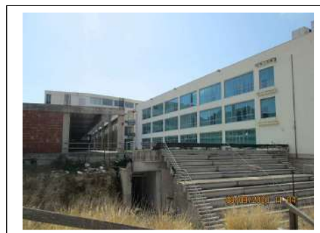
Foto 28. Gradonata esterna a prosecuzione della corte sotto la quale è ubicato l'auditorium
