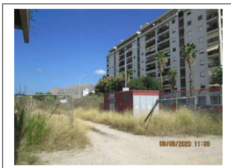
Foto 22. Cabina elettrica identificata al sub. 10 della p.lla 1050
