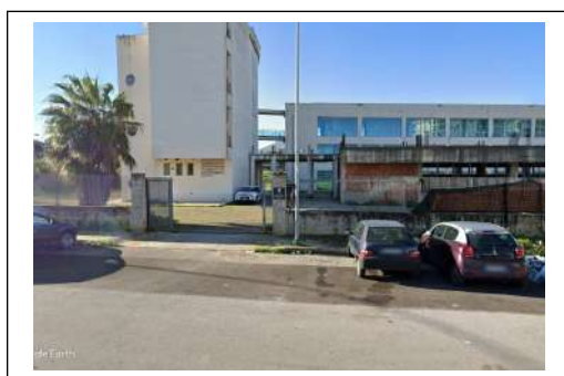
Foto 71. Ingresso da via Eleonora Duse n. 2
