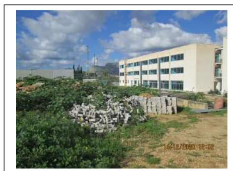
Foto 5. Edificio non pignorati facenti parte del complesso scolastico. Veduta del fronte ovest
