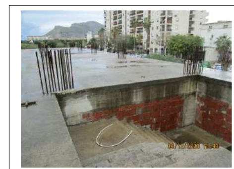
Foto 81. Edificio in corso di costruzione. Estradosso del solaio del piano terra e corpo scala
