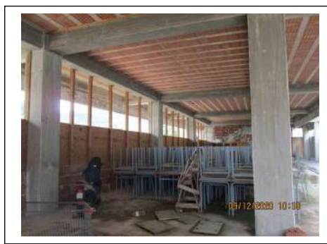
Foto 88. Edificio in corso di costruzione. Interno
