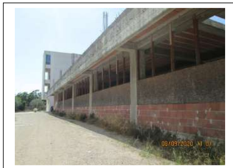
Foto 75. Edificio in corso di costruzione. Lato est
