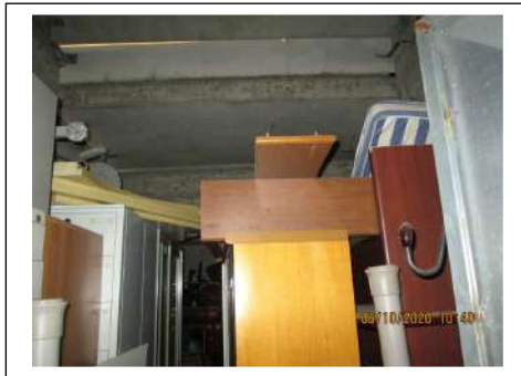
Foto 49. Locale di sgombero sotto la gradonata esterna
