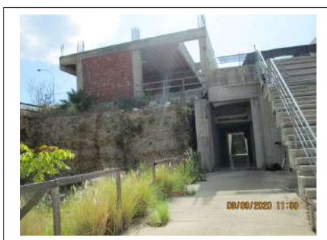
Foto 29. Ingresso ai corridoi coperti che conducono all'auditorium dalla zona antistante la gradonata esterna
