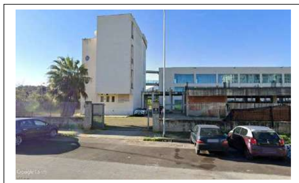
Foto 16. Cancelli di ingresso da via Eleonora Duse n. 2
