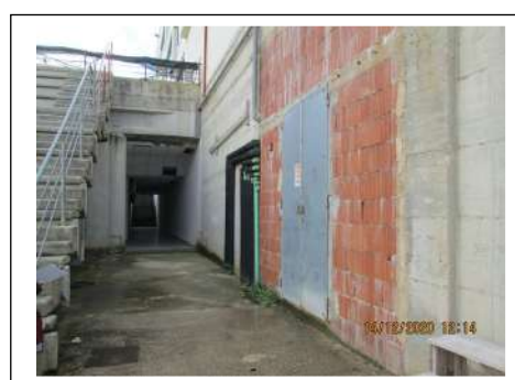
Foto 30. Ingresso ai corridoi coperti che conducono all'auditorium dalla zona antistante la gradonata esterna
