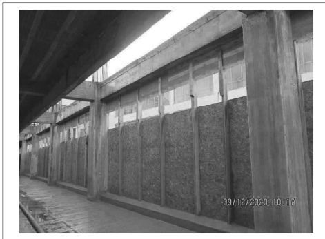
Foto 87. Edificio in corso di costruzione. Interno
