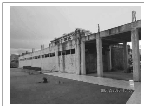
Foto 76. Edificio in corso di costruzione. Lato ovest prospettante sulla corte
