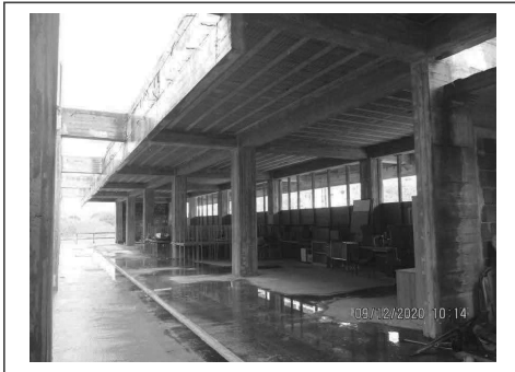
Foto 85. Edificio in corso di costruzione. Interno
