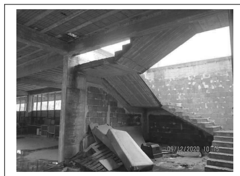
Foto 82. Edificio in corso di costruzione. Corpo scala
