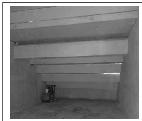
Foto 52. Locale di sgombero sotto la gradonata esterna
