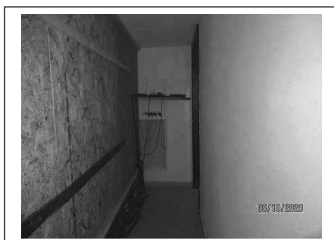
Foto 43. Ingresso ai servizi igienici ubicati ai lati del palco sotto le rampe di scale che conducono alla corte
