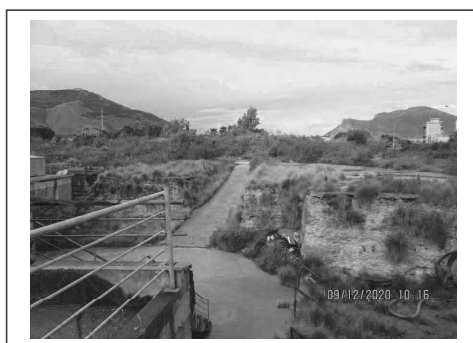
Foto 67. Area urbana. Zona ubicata a nord antistante l'auditorium
