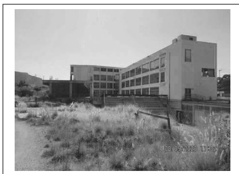
Foto2. Edifici facenti parte del complesso scolastico disposti attorno ad una corte comune. Veduta del fronte nord
