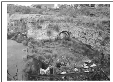
Foto 89. Scavo di sbancamento del prolungamento dell'edificio in corso i costruzione
