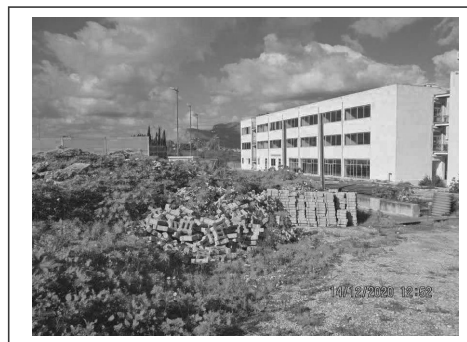
Foto 62. Area urbana. Lato sud-ovest
