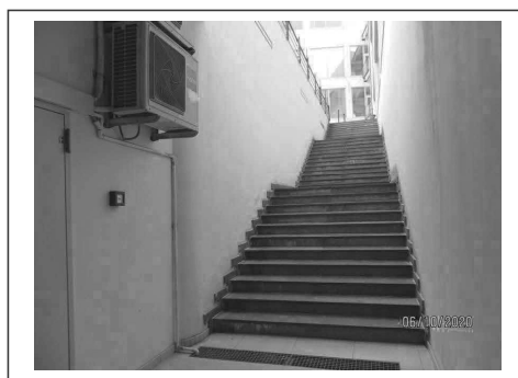
Foto 27. Rampe di scale che dalla quota della corte conducono all'auditorium seminterrato
