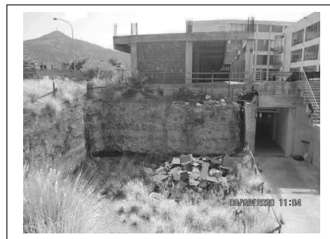
Foto 90. Scavo di sbancamento del prolungamento dell'edificio in corso i costruzione
