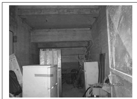
Foto 51. Locale di sgombero sotto la gradonata esterna
