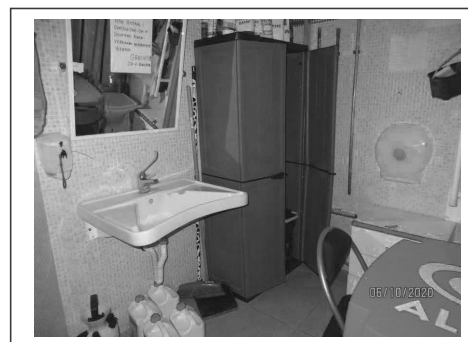
Foto 46. Servizio igienico per disabili con accesso dal foyer
