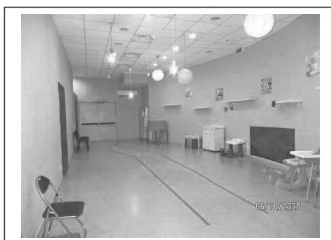
Foto 37. Foyer dell'auditorium all'atto del sopralluogo del 06/10/2020
