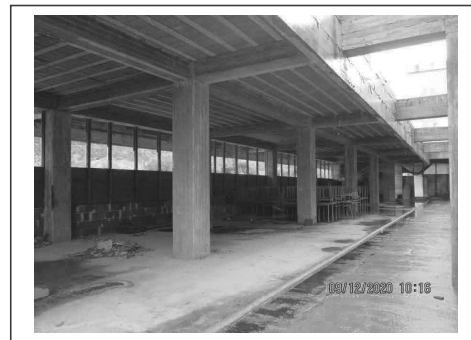
Foto 86. Edificio in corso di costruzione. Interno
