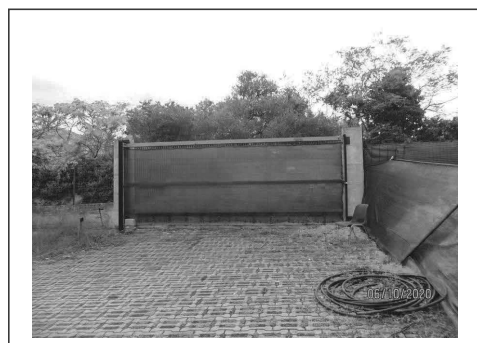
Foto 73. Ingresso carrabile da via Casino Grande
