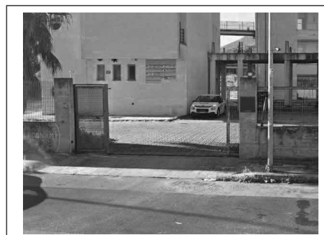
Foto 72. Ingresso da via Eleonora Duse n. 2
