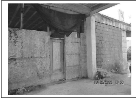
Foto 83. Edificio in corso di costruzione. Zona di ingresso
