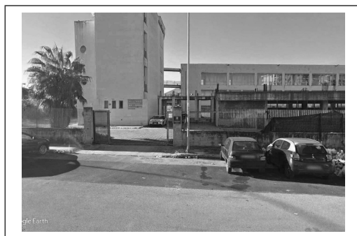
Foto 71. Ingresso da via Eleonora Duse n. 2
