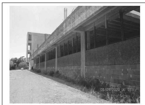
Foto 75. Edificio in corso di costruzione. Lato est
