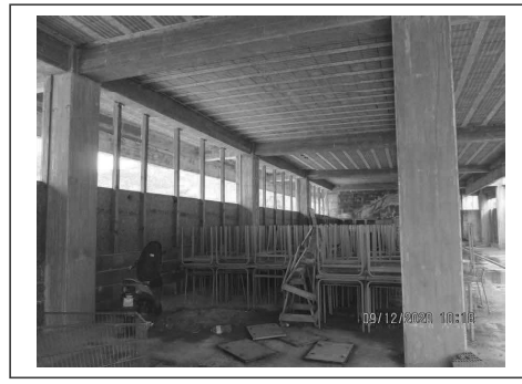
Foto 88. Edificio in corso di costruzione. Interno
