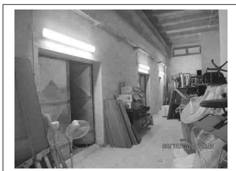
Foto 47. Locale di sgombero adiacente al foyer
