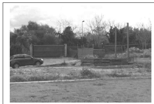
Foto 17. Cancelli di ingresso da via Casino Grande
