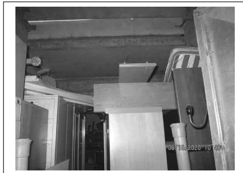
Foto 49. Locale di sgombero sotto la gradonata esterna
