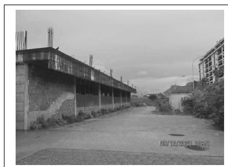
Foto 7. Fabbricato in corso di costruzione oggetto di pignoramento identificato al sub. 14. Veduta del fronte est
