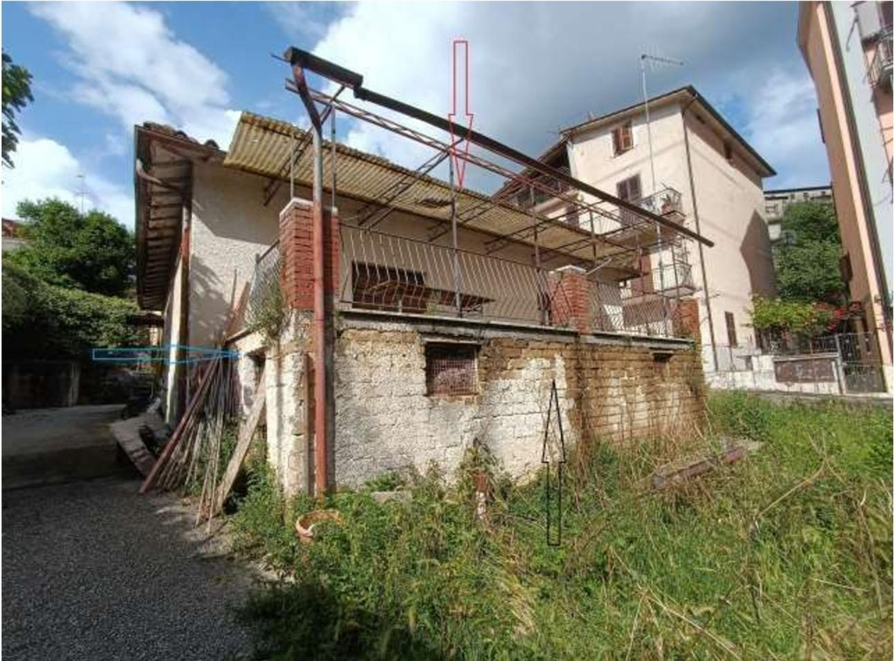
**Freccia Rossa**= Tettoia da rimuovere e sostituire con una in legno
