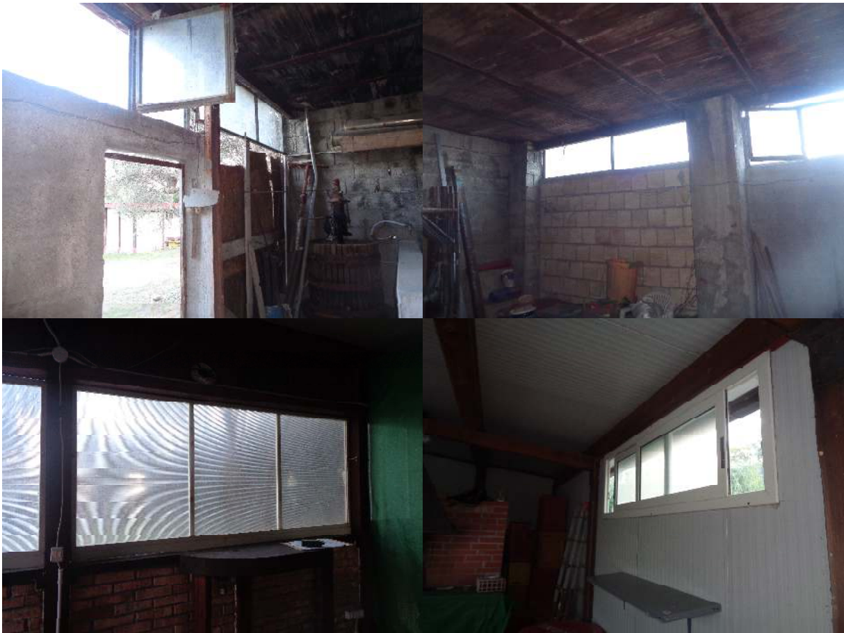
Fig.19 - Foto – Siderno. (RC) Vista interna – locali deposito -primo Contrada Grappidaro foglio 16 part. 988-sub 6
