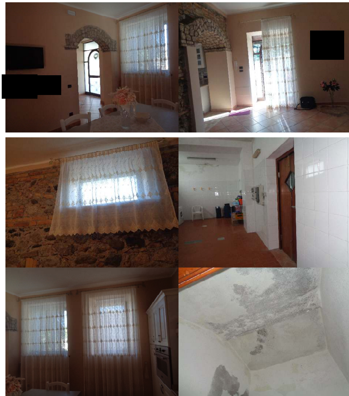
Fig.17 - Foto – Siderno. (RC) Vista interna sub 7 – piano seminterrato Contrada Grappidaro foglio 16 part. 988-sub 7
