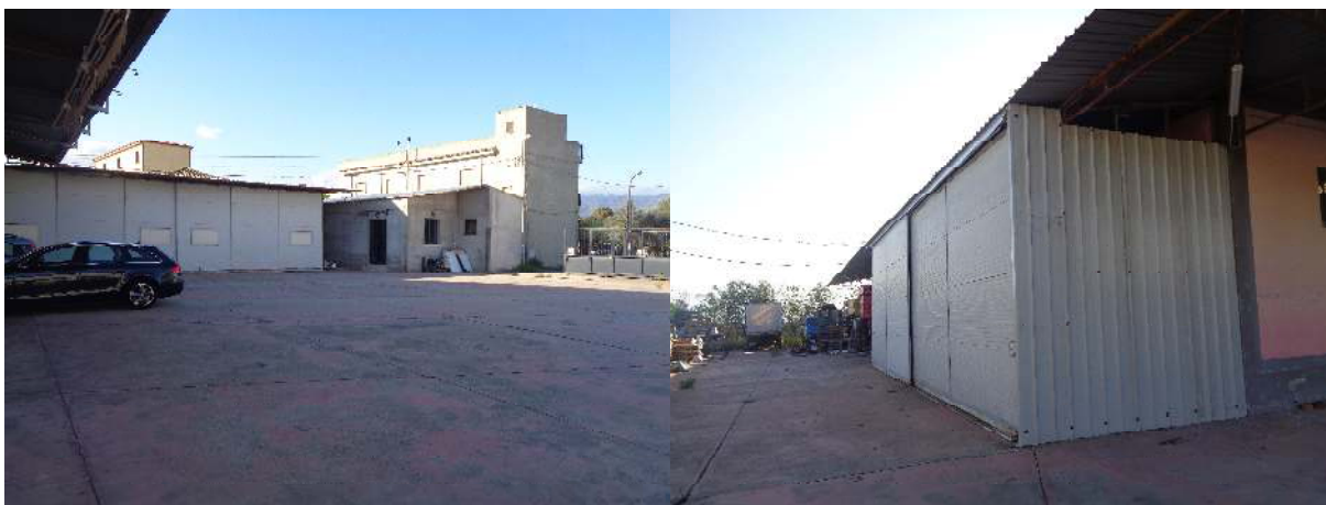
Fig. 9- Foto – Siderno- Vista Esterna Capannone
