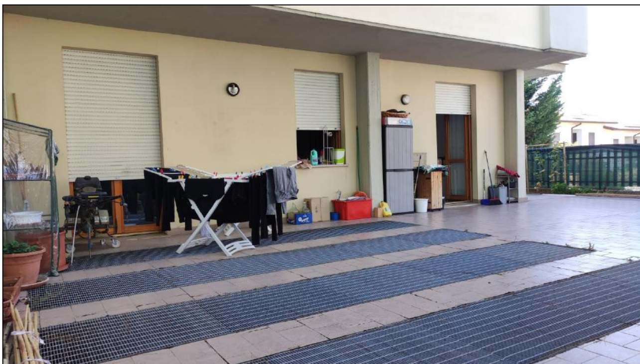
Vista Esterna - Prospetto Nord-Ovest e Terrazzo e/o Lastrico Solare
