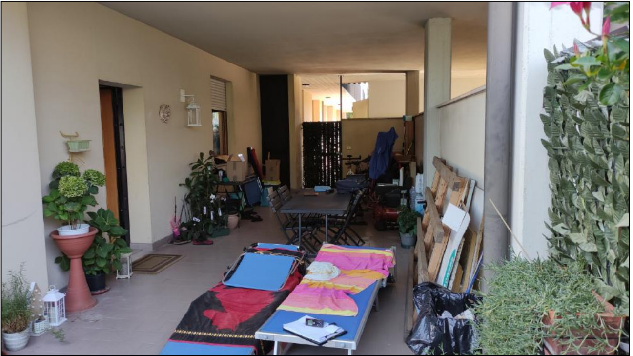
Vista Esterna - Vista Prospetto Sud-Est e Portico Coperto
