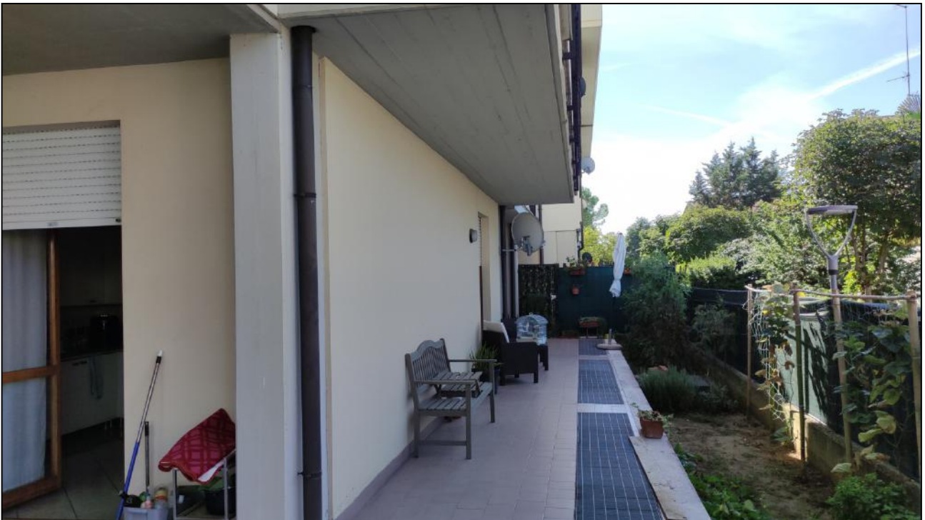
Vista Esterna - Vista Prospetto Sud-Ovest, Terrazzo e/o Lastrico Solare e Orto e/o Giardino
