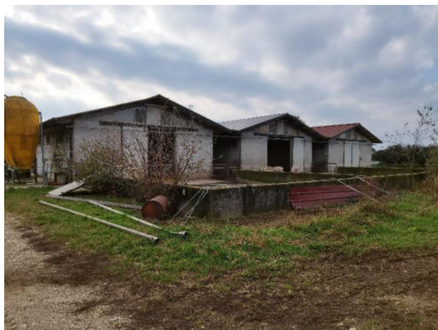
Esterni Edifici 1, 2 e 3 (porcilaie)
