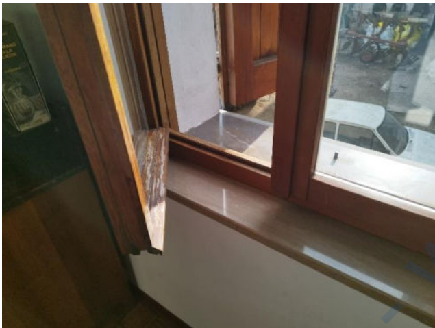
Particolare serramenti esterni
