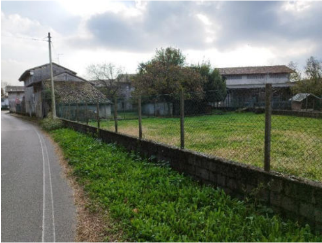
Scoperto pertinenziale posto a nord
