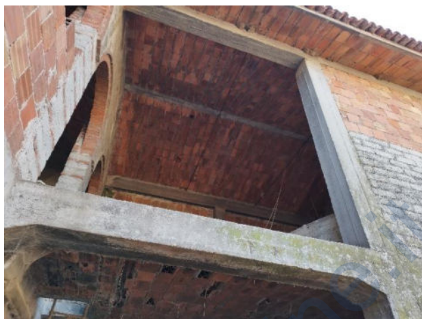
Interni fienile piano primo visto dal PT
