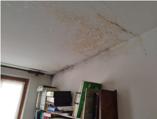
Particolare infiltrazione
