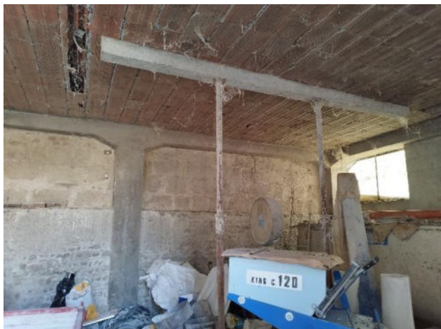
Interni deposito piano terra
