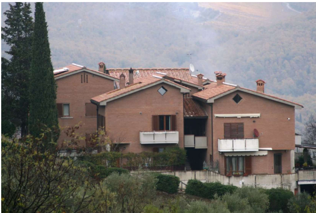
Vista lato Ovest – accesso appartamento P1°
