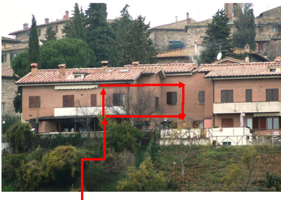
Vista balconcino, porta-finestra e finestra soggiorno e finestra camera
