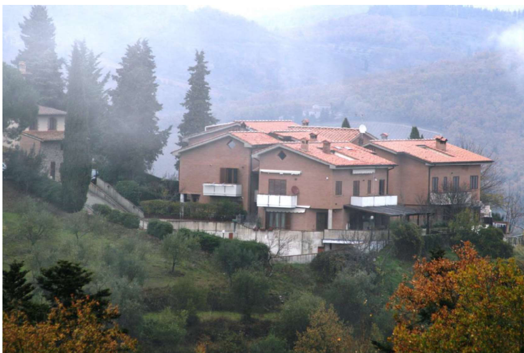
Vista lato Ovest - panoramica
