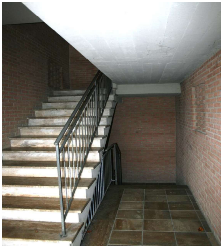
Ingresso scala al P.1° e scala al P. Seminterrato
